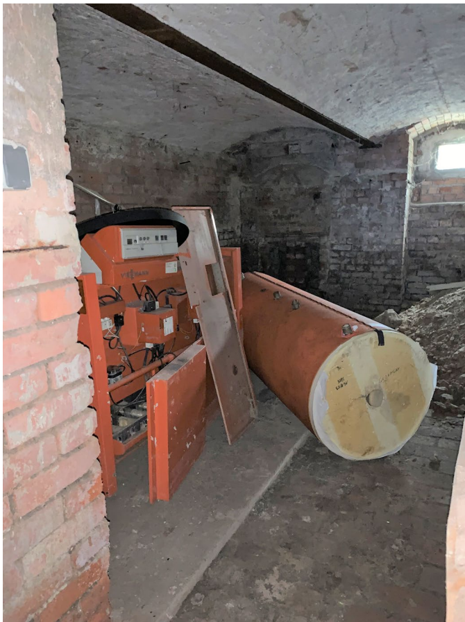
Abb. 10 Teilansicht Heizraum mit ehemaliger Gasheizungsanlage
