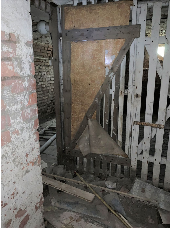
Abb. 09 Kellergeschoss, Teilansicht von Kellerräumen, ohne Zuordnung
