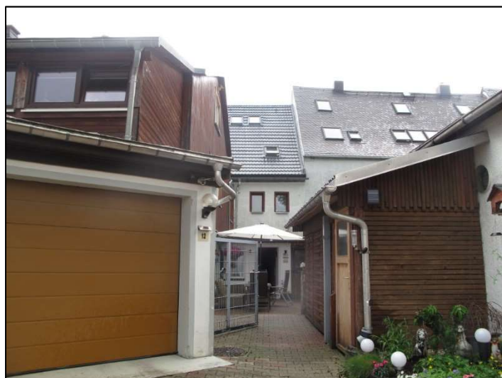
Ansicht auf Hintergebäude und Vorderhaus von hinten
