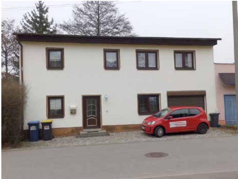
Bild 1: Straßenansicht des Wohngebäudes
