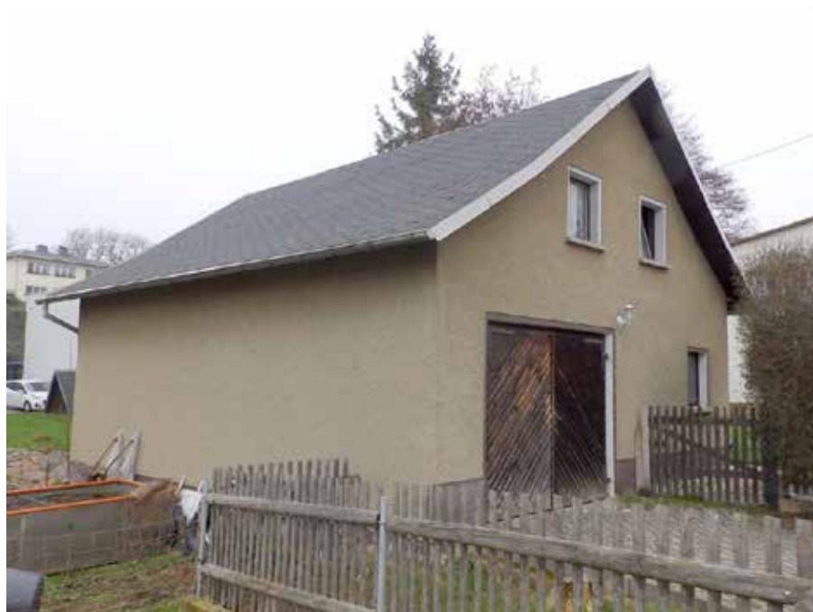
Bild 2: Straßenansicht des Werkstatt- / Garagengebäudes
