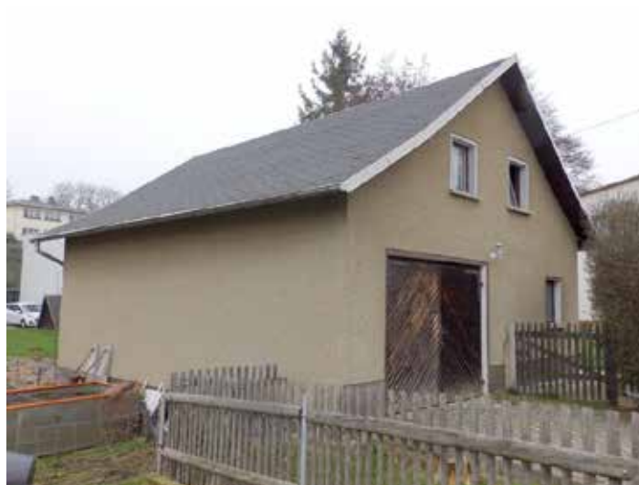
Bild 12: Straßenansicht des Werkstatt- / Garagengebäudes
