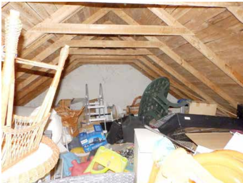
Bild 16: Dachgeschoss des Werkstatt- / Garagengebäudes
