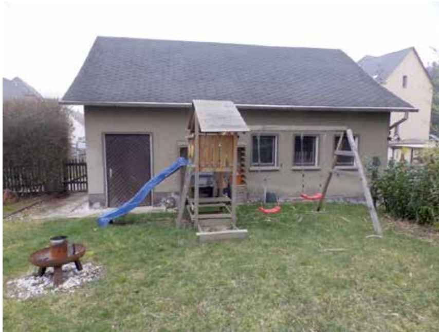
Bild 13: Ansicht des Werkstatt- / Garagengebäudes vom Garten aus
