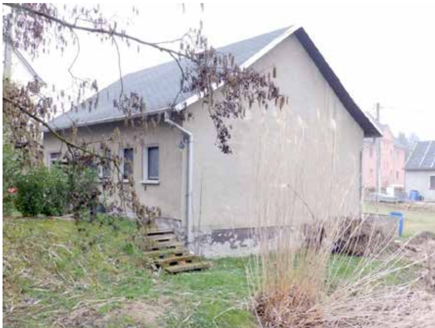
Bild 14: Ansicht des Werkstatt- / Garagengebäudes aus nordöstlicher Richtung
