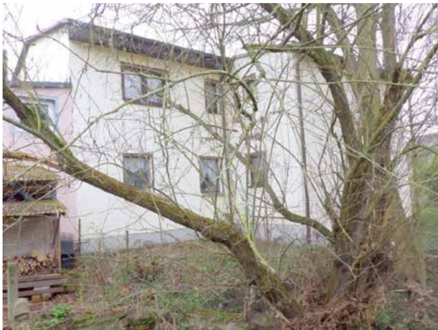
Bild 4: Ansicht des Wohngebäudes aus nördlicher Richtung
