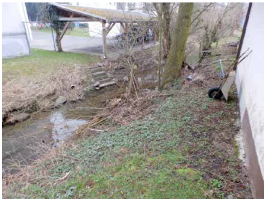
Bild 10: Blick entlang der nördlichen Gebäudeseite des Wohngebäudes
