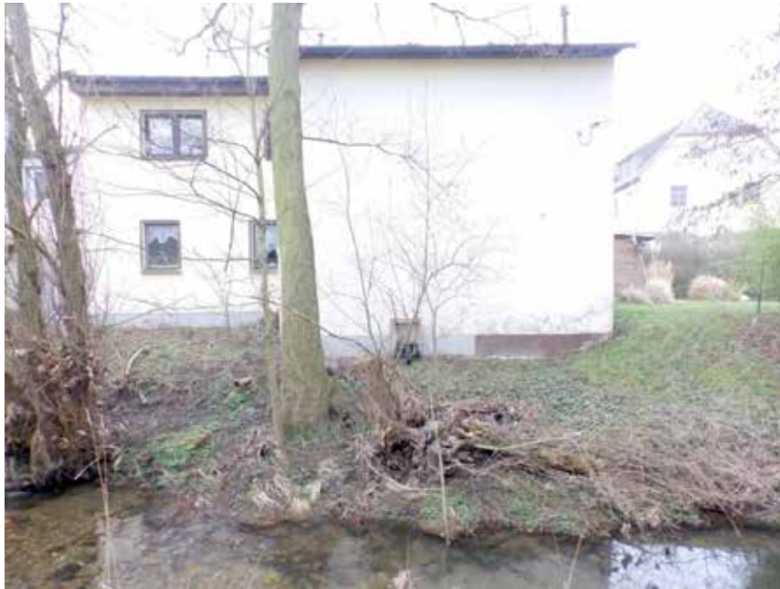
Bild 5: Ansicht des Wohngebäudes aus nördlicher Richtung
