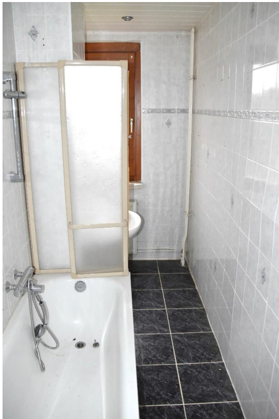
Eigentumswohnung 9, Bad, großflächig lose Fliesen erkennbar
