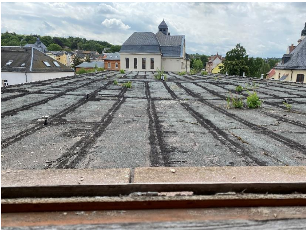
Bild 17, Blick von der obersten Etage des gemauerten Gebäudeteils auf das Dach des Gebäudeteils „Plattenbau“ in Richtung Süden
