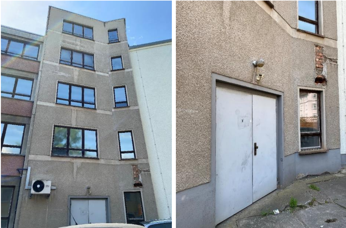
Bilder 13 und 14, Ansicht des gemauerten, fünfgeschossigen Gebäudeteils mit Hauseingang von Osten
