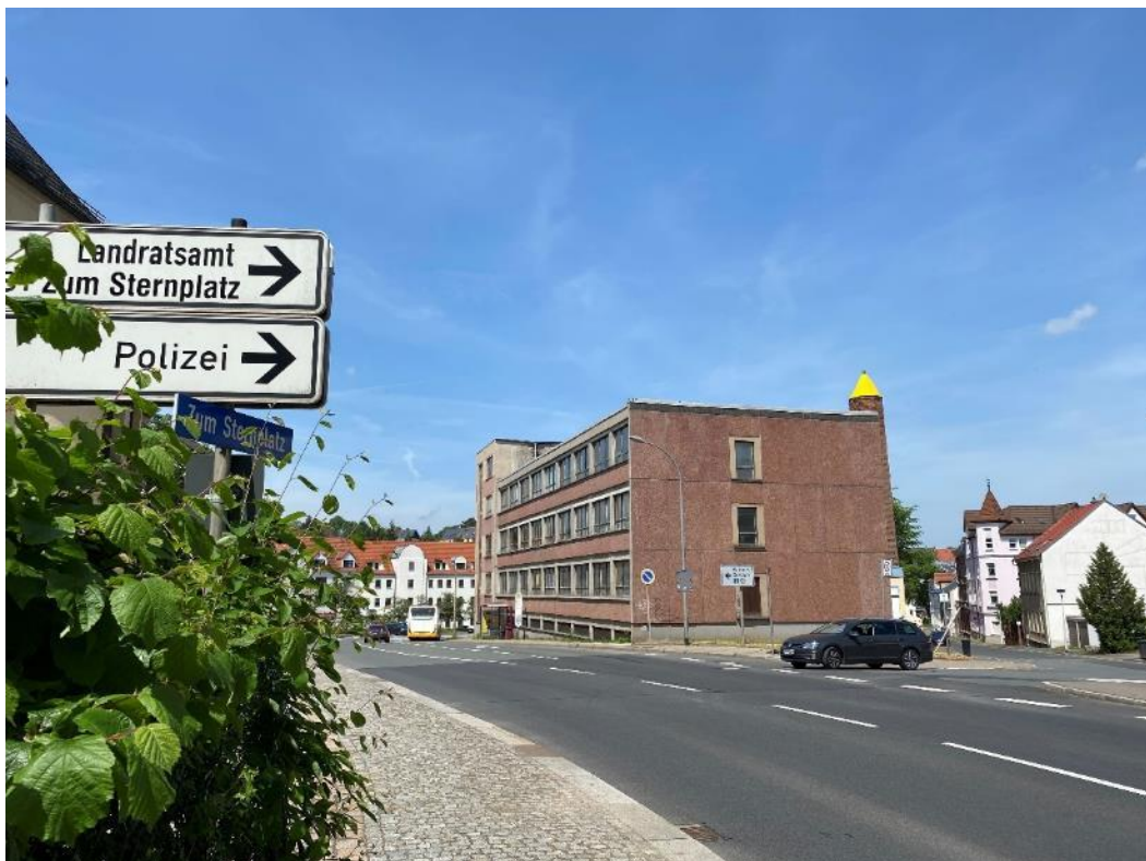
Bild 2, Ansicht des Eckgrundstücks Zum Sternplatz 5 von Süden
