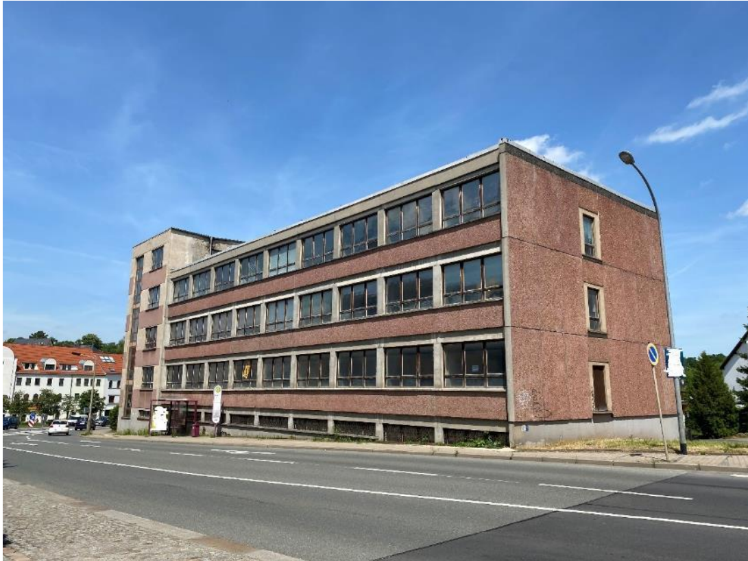
Bild 3, Blick auf das Bewertungsgrundstück von Süd-Westen
