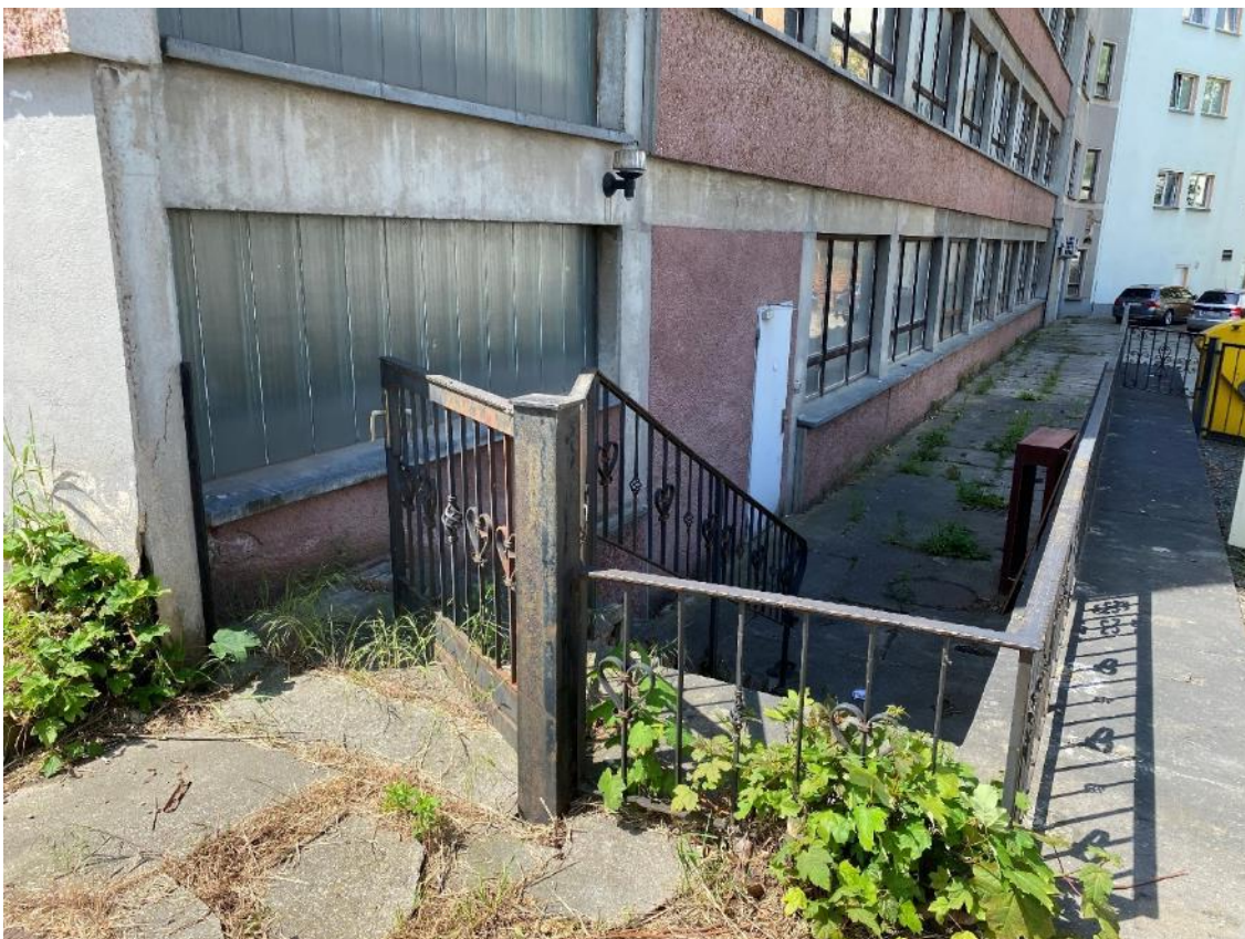
Bild 15, Die nord-östliche Grundstücksgrenze verläuft in einem Abstand von ca. 2,50 – 3 m vor der Gebäuderückseite
