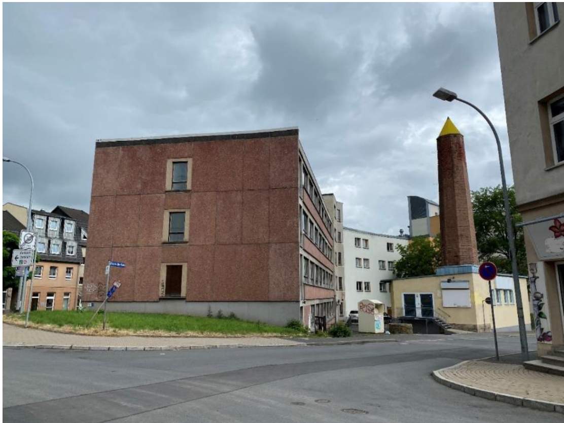
Bild 9, Blick auf das Bewertungsobjekt von Süd-Osten (von der Heinrich-Zille-Straße bzw. Gneisenaustraße)
