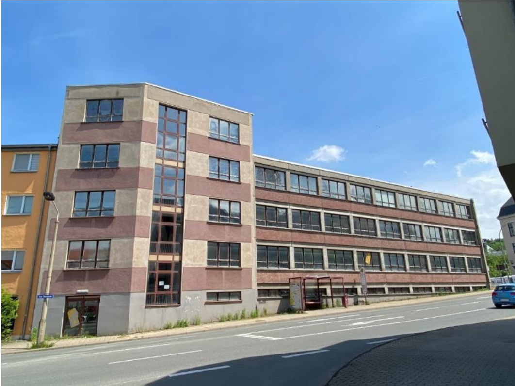
Bild 5, Ansicht von Westen, links im Bild Gebäudeteil aus Mauerwerk (5-geschossig), rechts Plattenbau
