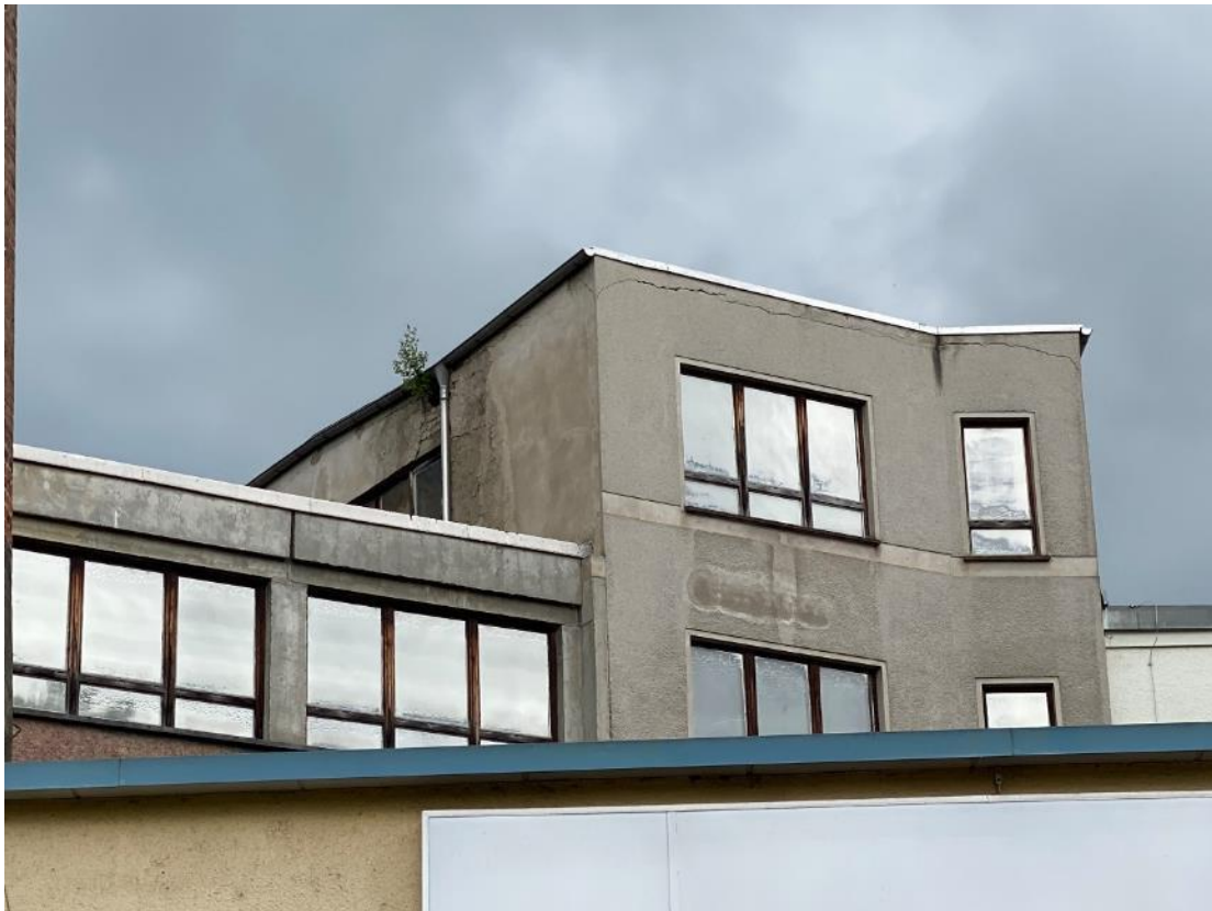
Bilder 11 und 12, Details Dachentwässerung und Traufe/Ortgang (Gebäudeteil Mauerwerksbau)
