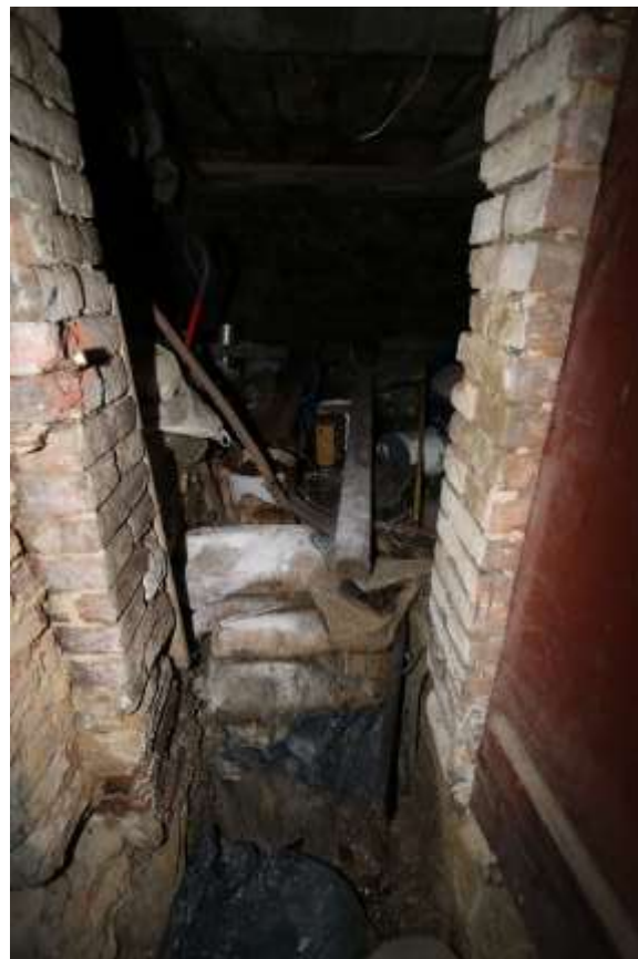
Foto 12: Blick in den Keller
