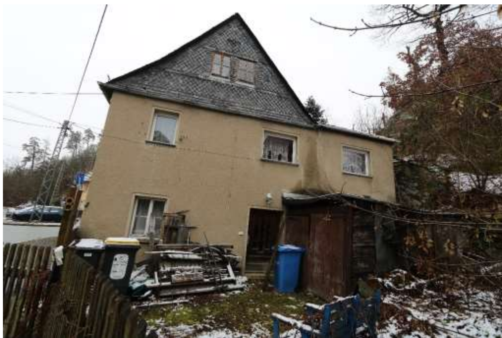
Foto 6: SO-Ansicht mit Hauseingang
