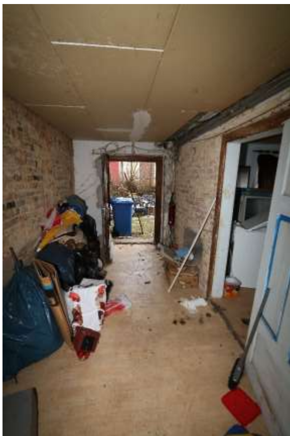
Foto 11: EG, Flur mit Hauseingang
