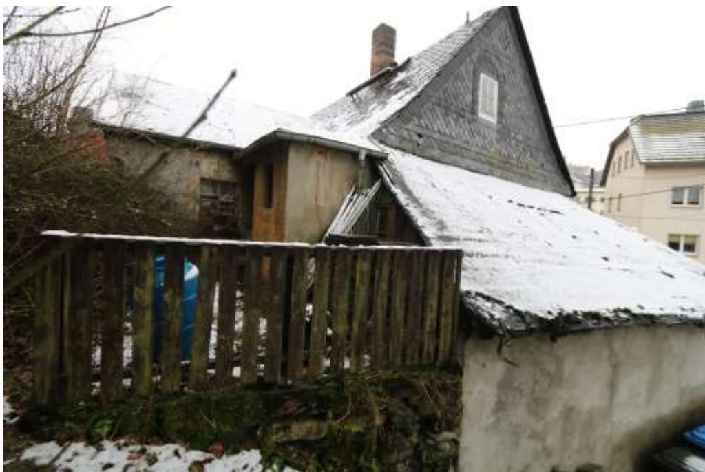
Foto 9: Blick in den Innenhof
