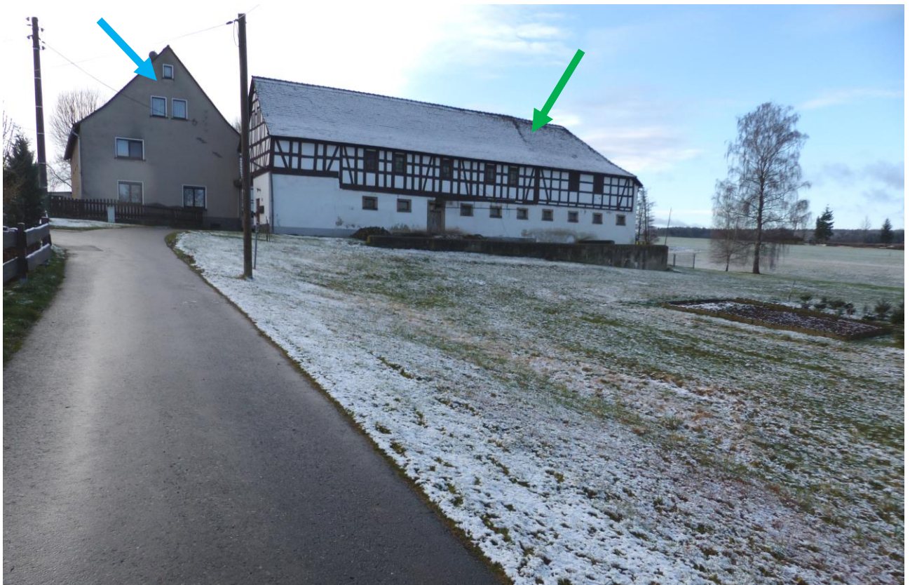
Ansicht aus nördlicher Richtung von der Grundstückszufahrt, blau: Wohneinheit Nr. 1 grün: Scheune (Sondernutzungsrecht für Wohneinheit Nr.1)
