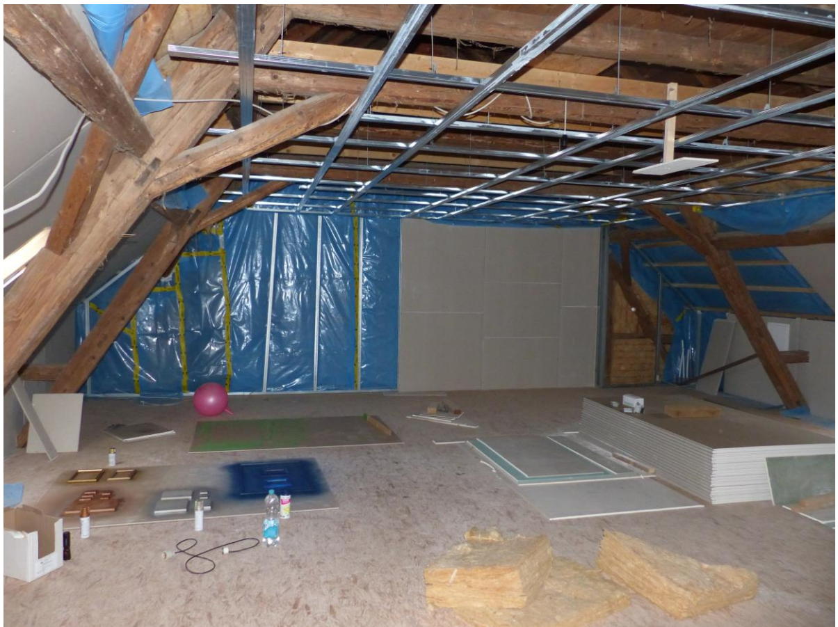
mit dem Innenausbau begonnenes Dachgeschoss der Wohneinheit Nr. 3
