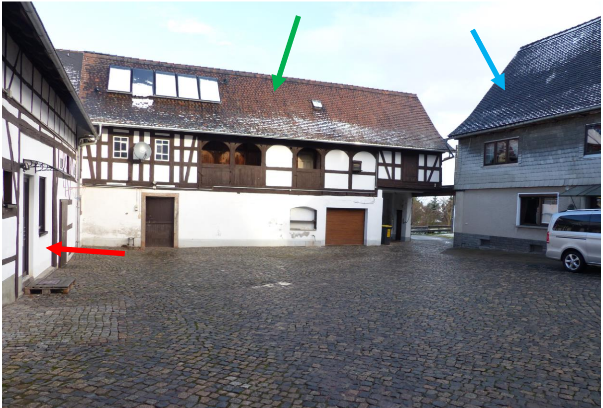
Innenhof mit Zufahrt, Wohneinheit Nr. 3 (rot), blau: Wohneinheit Nr. 1, grün: Scheune (Sondernutzungsrecht für Wohneinheit Nr.1)
