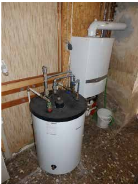
Bild 7: Heizkessel, Warmwasserbereiter
