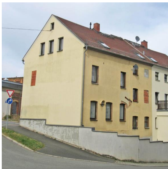
Rückansicht von der Kreuzung Turner-/Feldstraße nach Süden
