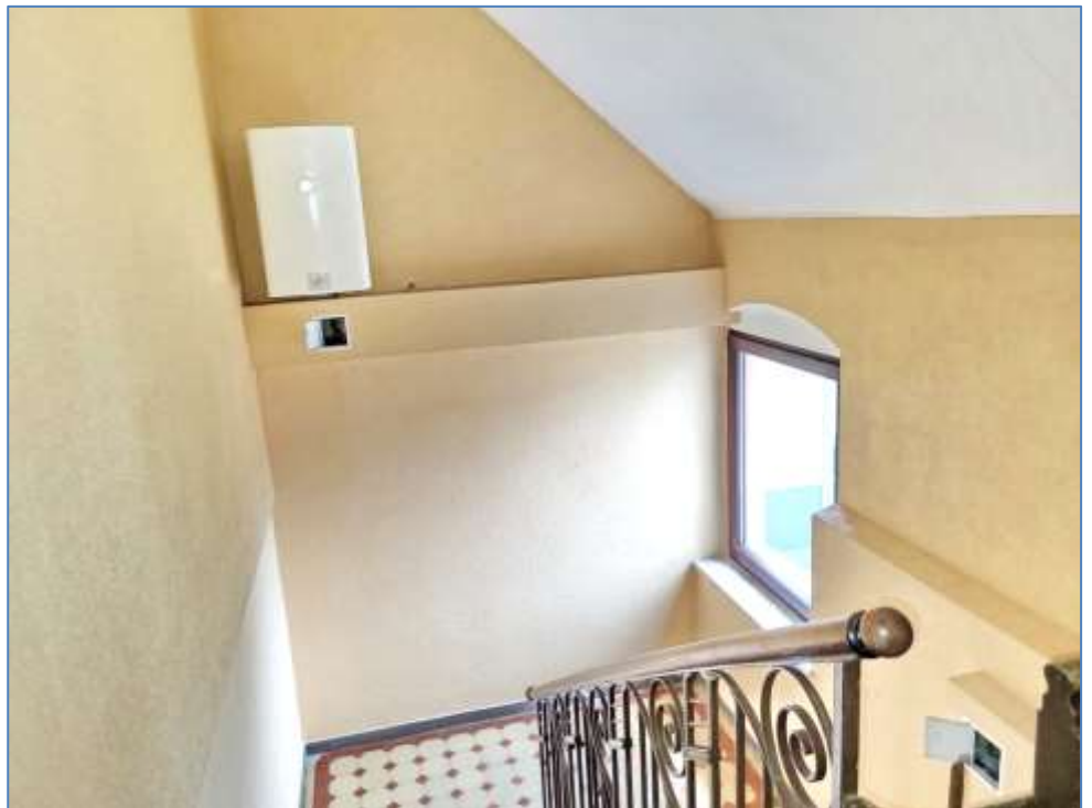
Bild 20 Detail Treppenhaus im Dachgeschoss
