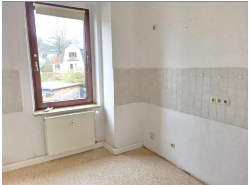
Bild 16 Küche einer Wohnung im 2. Obergeschoss
