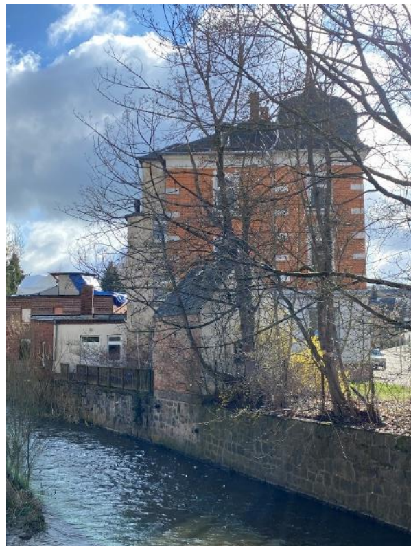
Bild 7, Bachmauer zum Rödelbach an der nord-westlichen Grundstücksgrenze
