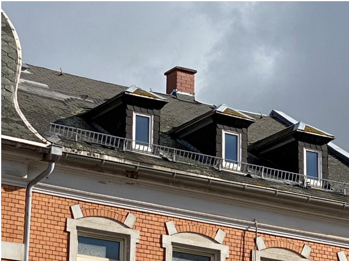
Bild 13, Detail des straßenseitigen Daches
