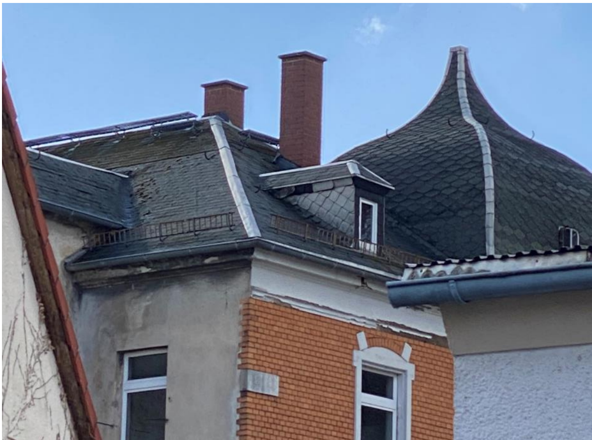
Bild 12, Detail des gebäuderückseitigen Daches
