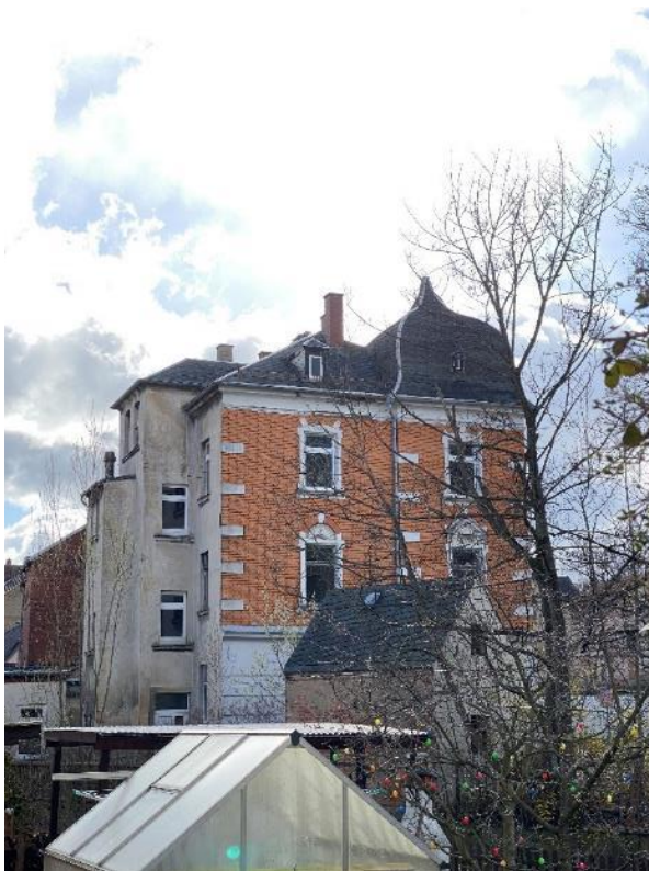
Bild 6, Ansicht der Gebäuderückseite von Nord-Westen
