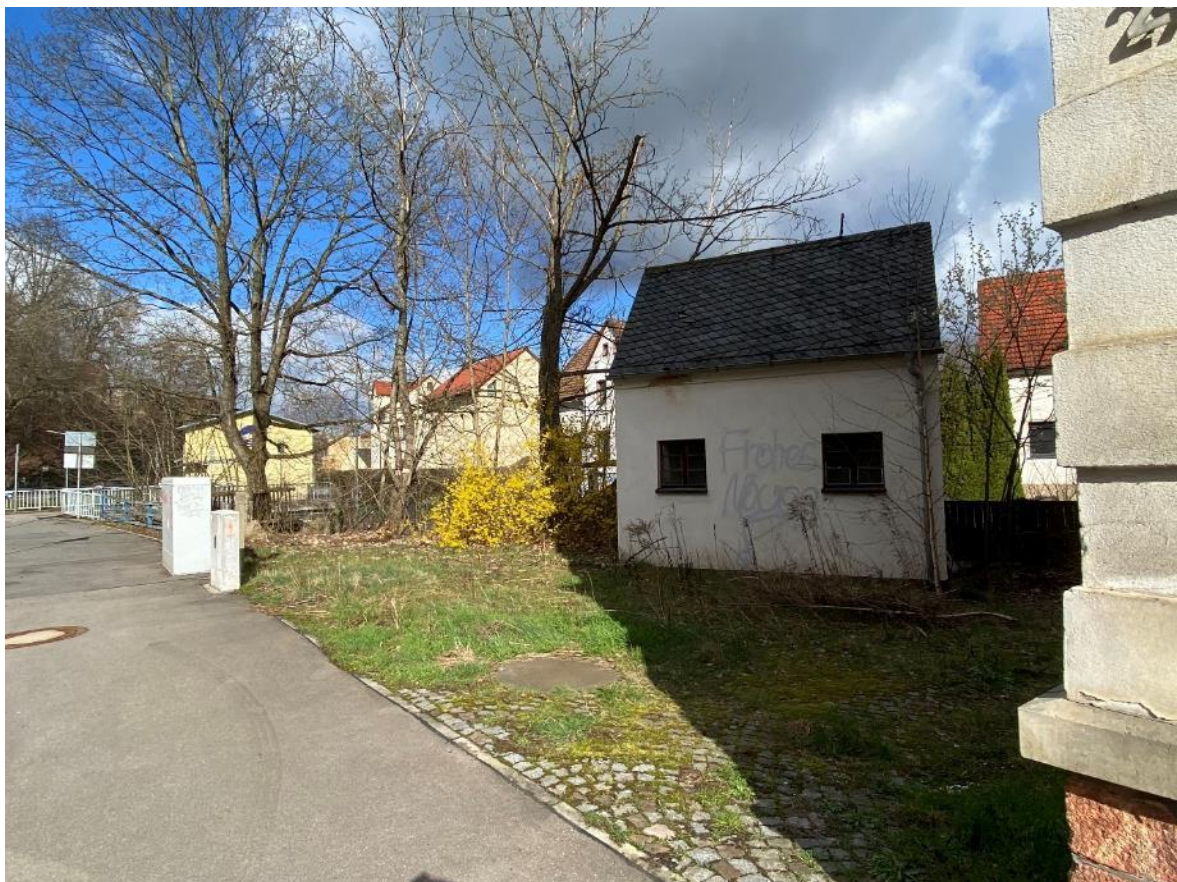
Bild 18, Blick auf den Hofbereich des Bewertungsgrundstücks in Richtung Westen (der Fußweg und Parkstreifen vor dem Haus ist Bestandteil des Bewertungsgrundstücks)
