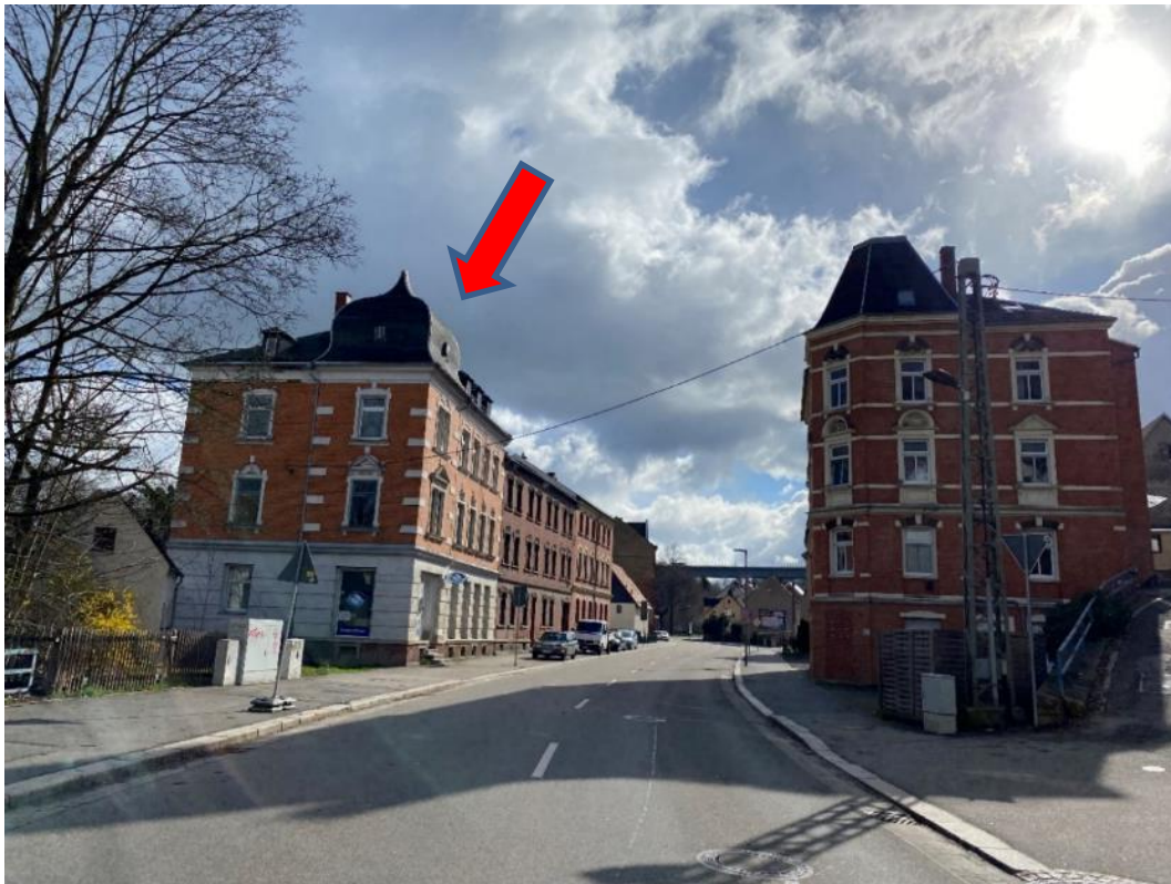
Bild 1, Blick in die Kirchberger Straße stadtauswärts mit Kennzeichnung der Lage des Bewertungsgrundstücks
