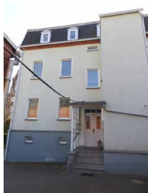
Bild 4: Ansicht des Mehrfamilienhauses vom rückwärtigen Grundstücksteil aus
