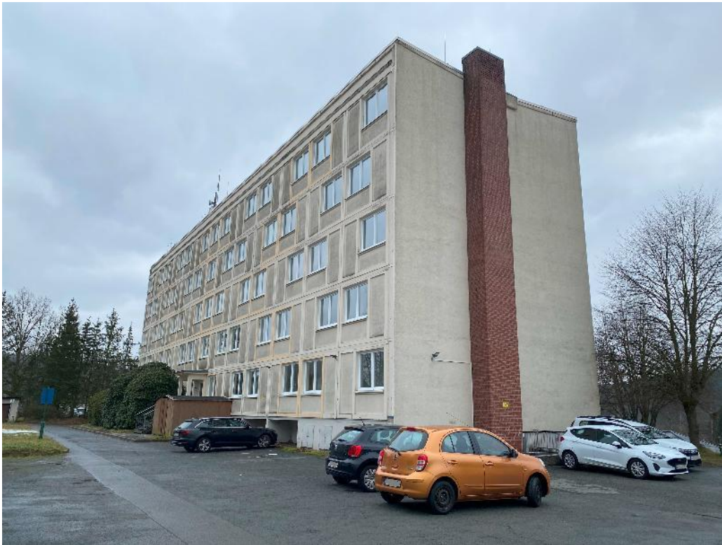
Bild 7, Ansicht der Gebäuderückseite mit Hauseingangsbereich von Nord-Westen
