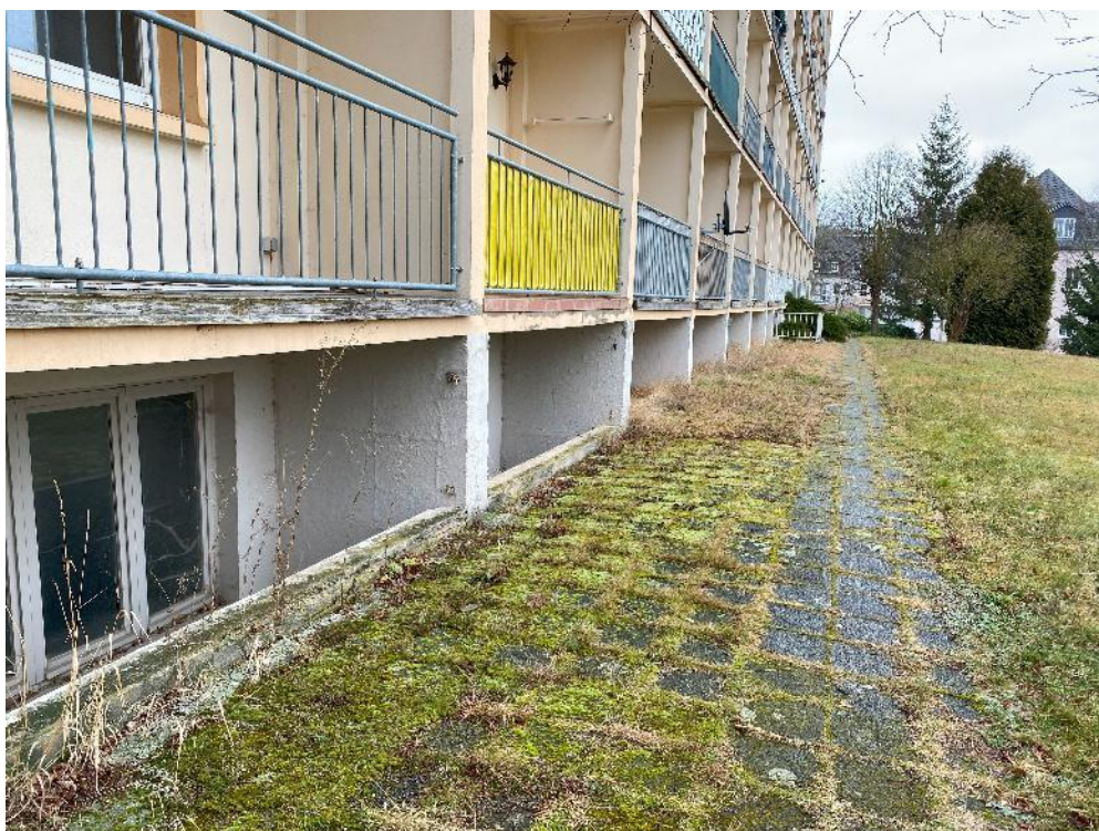
Bild 5, Weg entlang der straßenseitigen Gebäudelängsseite
