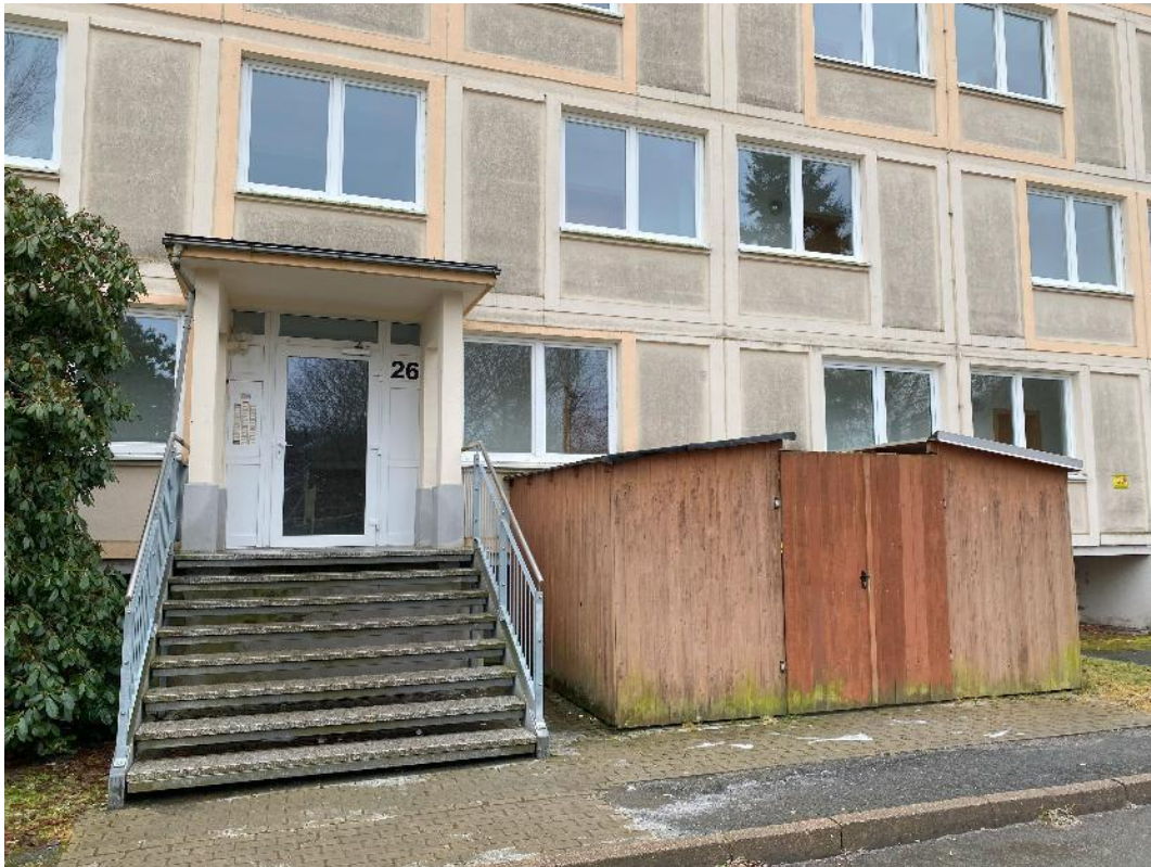
Bild 9, Hauseingangsbereich mit eingehaustem Mülltonnenplatz
