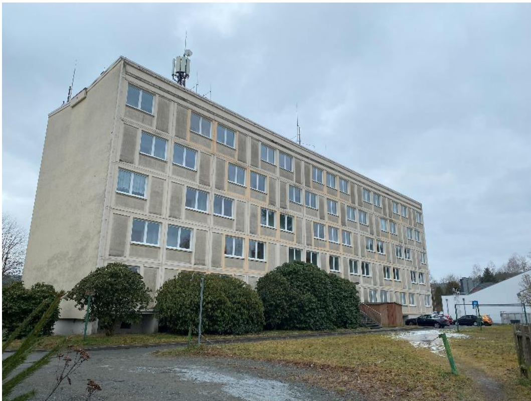
Bild 8, Ansicht von Norden
