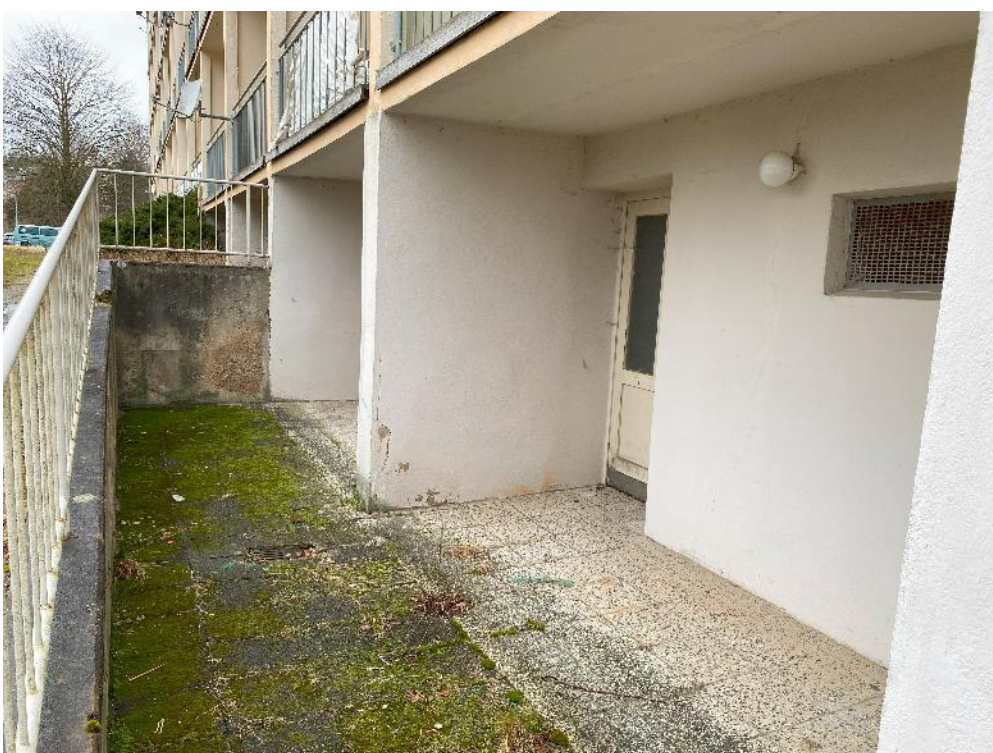
Bild 6, Zugang zum Fahrradraum
