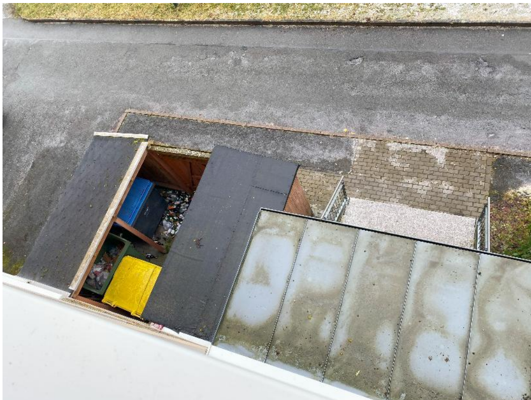
Bild 21, Blick vom Treppenhaus auf den Hauseingangsbereich mit Mülltonnenplatz
