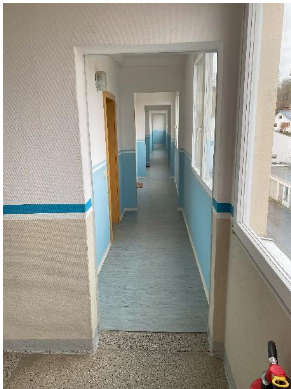
Bild 13, vom Treppenhaus abgehender Flur zu den Wohnungen
