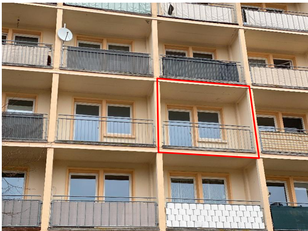
Bild 4, Loggia der Wohnung Nr. 32
