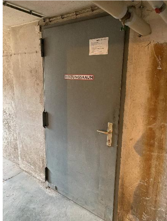
Bild 20, Tür zum Heizungsraum
