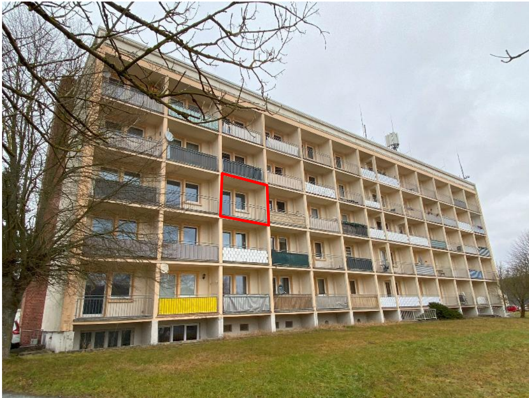
Bild 3, Ansicht von Süd-Westen mit Kennzeichnung der Lage der zu bewertenden Wohnung Nr. 32
