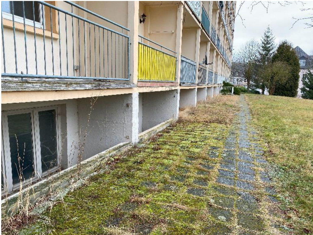
Bild 5, Weg entlang der straßenseitigen Gebäudelängsseite
