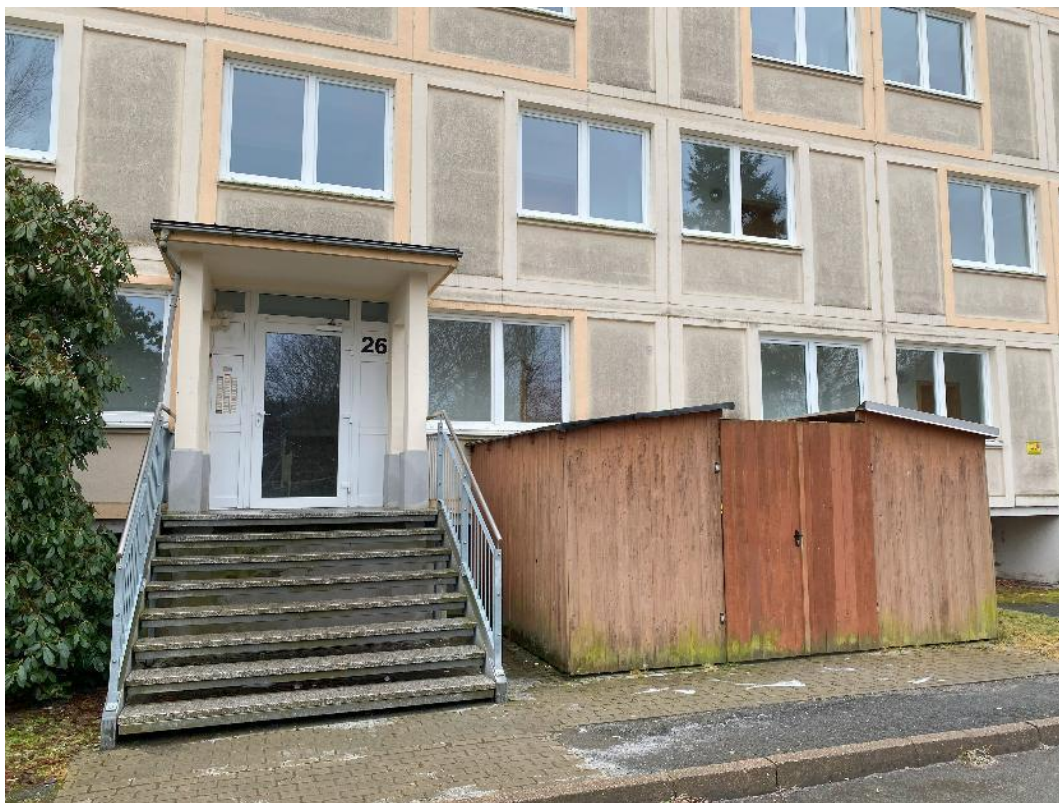
Bild 9, Hauseingangsbereich mit eingehaustem Mülltonnenplatz
