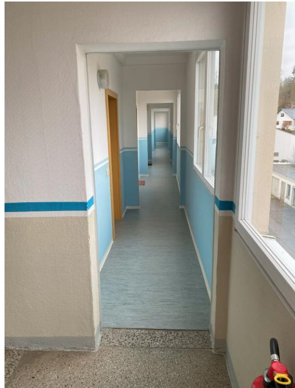
Bild 12, vom Treppenhaus abgehender Flur zu den Wohnungen
