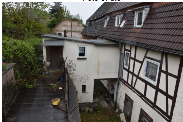
Foto 6: Nordansicht des Rückraumes
