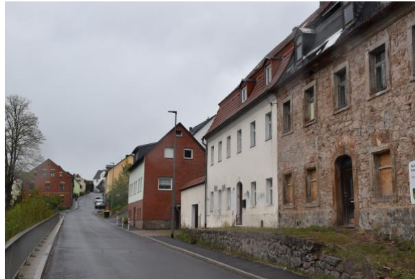
Foto 3: Südwestansicht mit umgebender Bebauung
