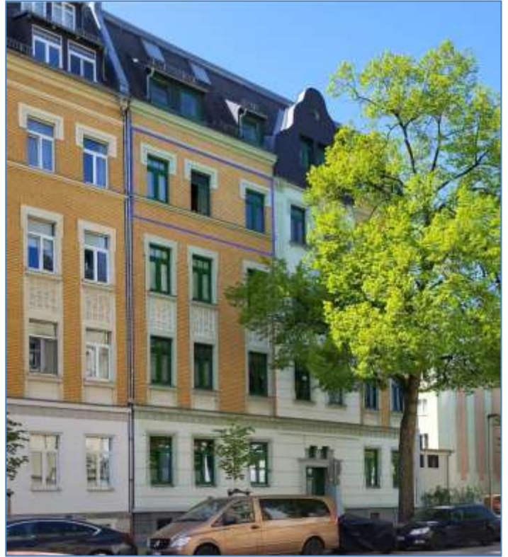
Bild 1 Eigentumswohnanlage, Straßenansicht von Nordost (Lage W 7 blau markiert)
