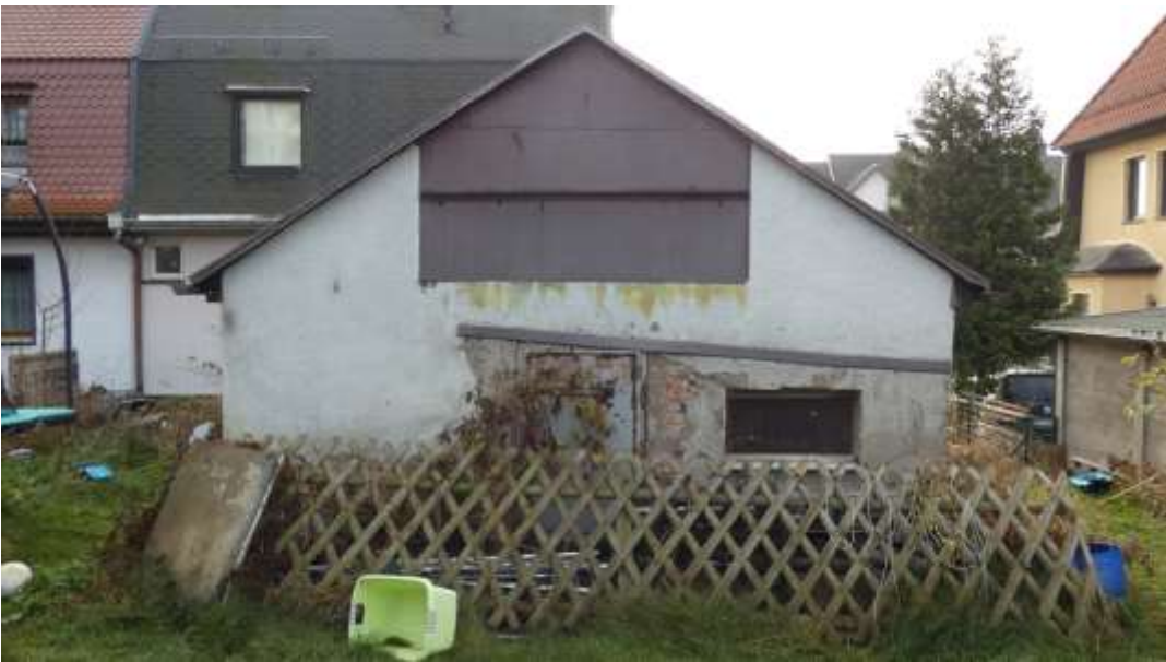
Gartenseitige Ansicht des Gargagengebäudes
