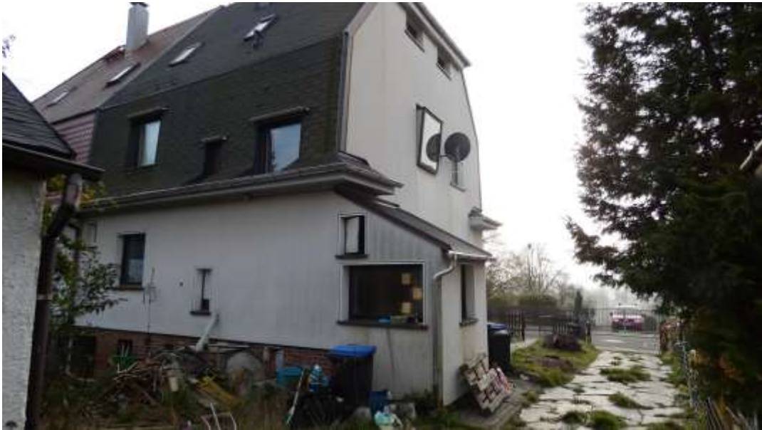
Blick auf die Doppelhaushälfte vom Garten aus fotografiert
