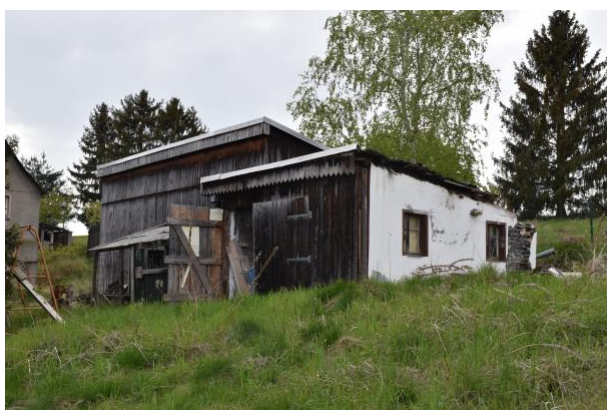
Foto 3: Ostansicht der Nebengebäude
