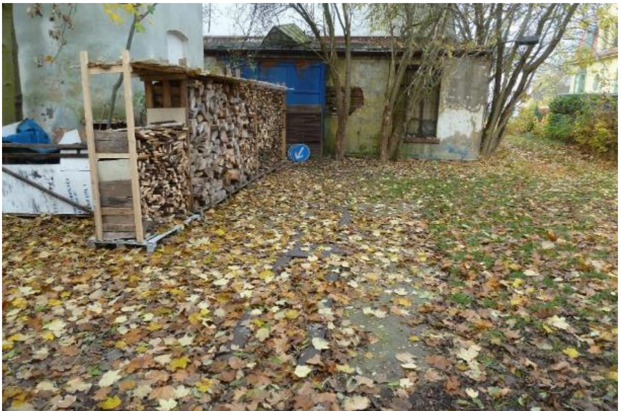
Bild 20, angebaute ehemalige Kfz-Werkstatt, im Vordergrund Bodenbefestigungen
