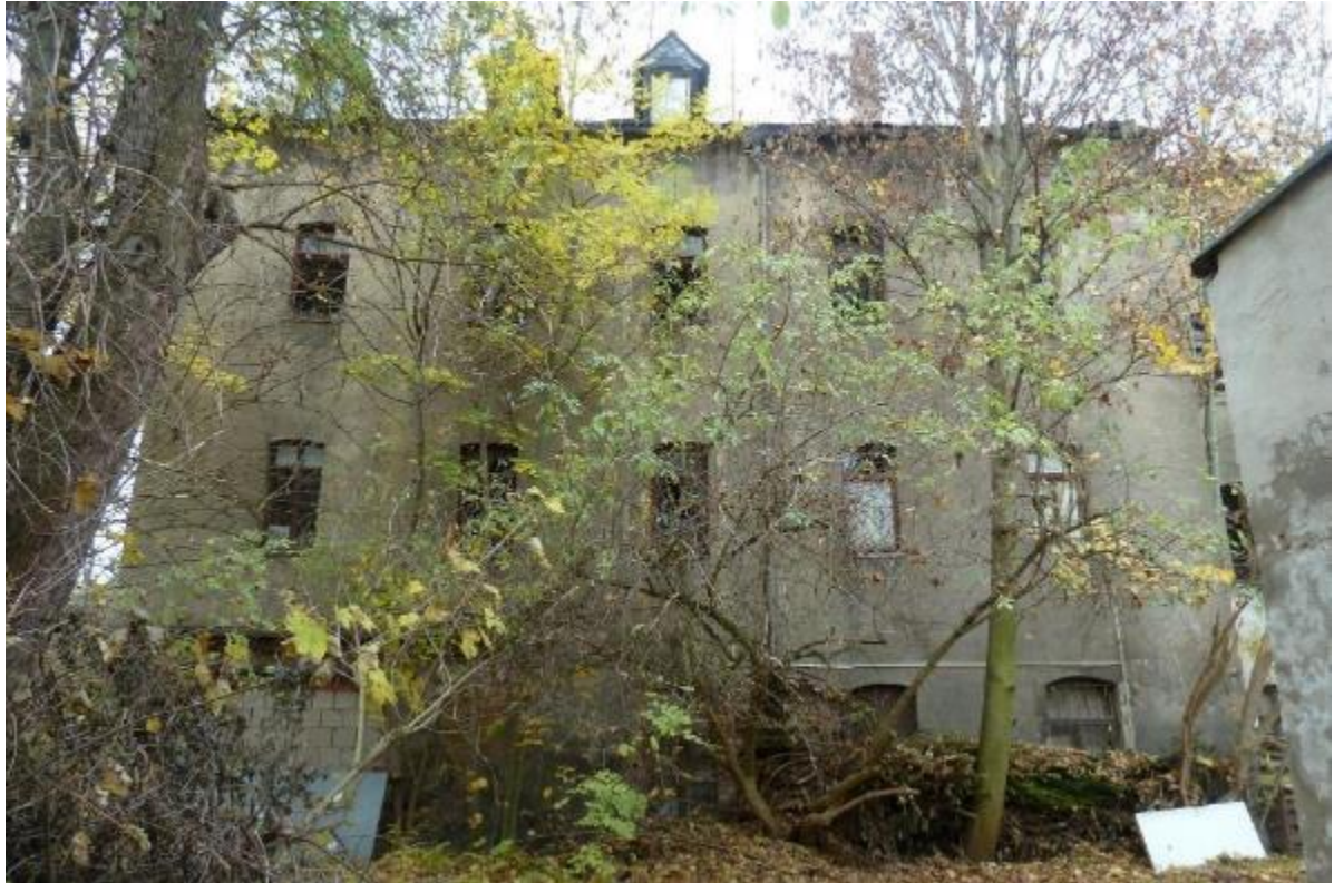
Bild 12, Ansicht des Wohnhauses von Osten
