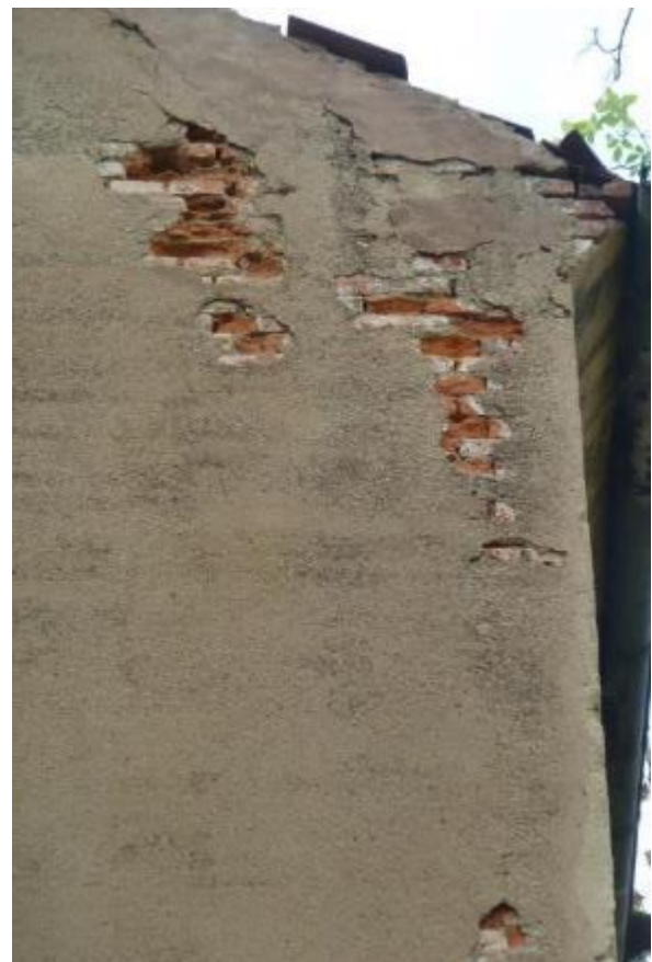
Bilder 15 und 16, Mauerwerksschäden am südlichen Giebel des Wohnhauses
