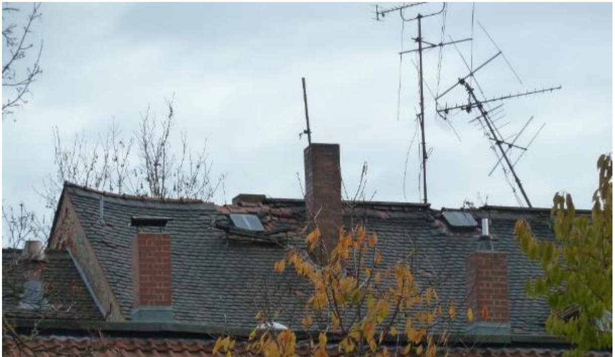
Bild 17, Dach des Wohnhauses von Westen
