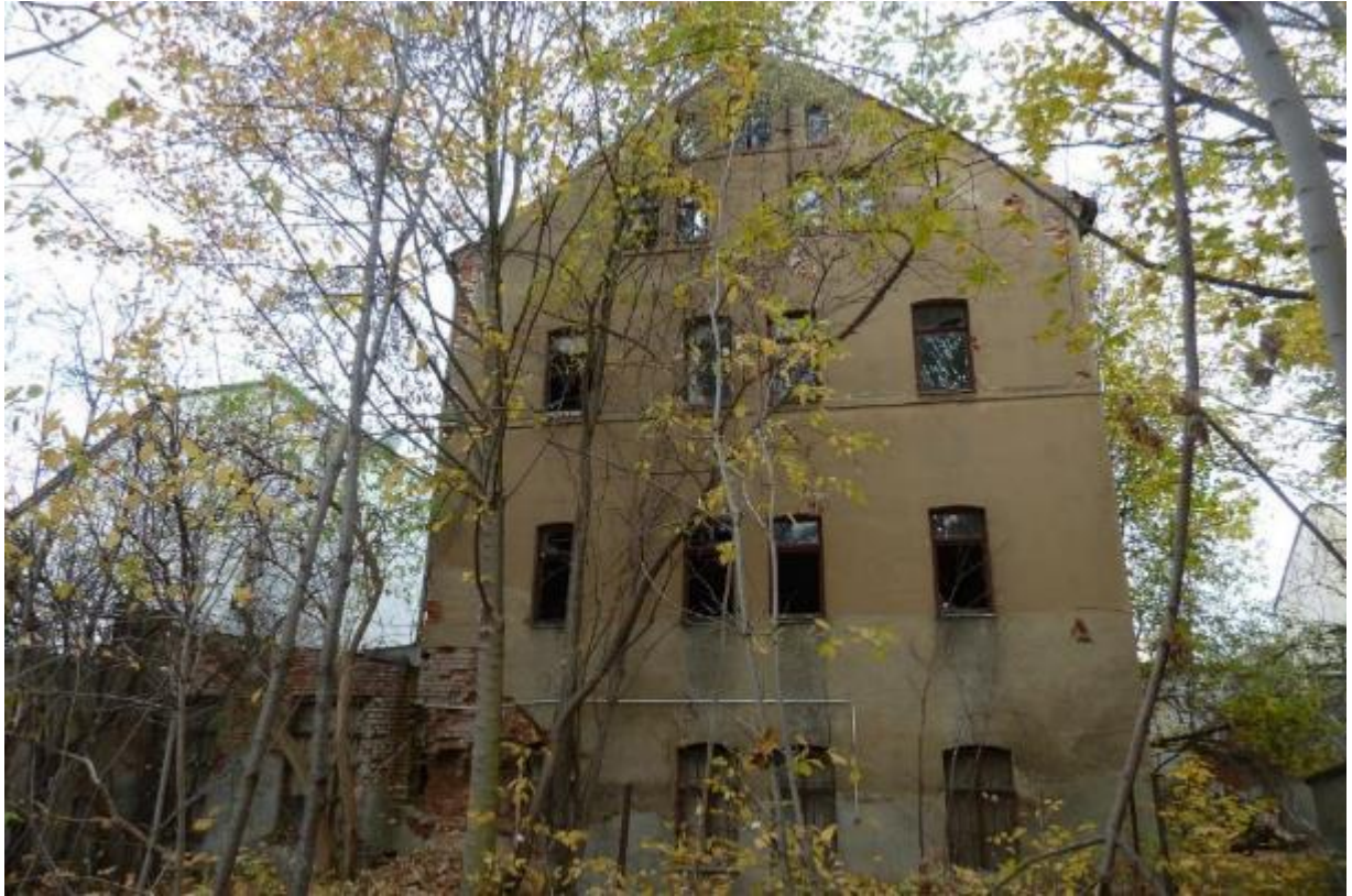
Bild 14, Ansicht von Süden, links im Bild die angebaute Kfz-Werkstatt
