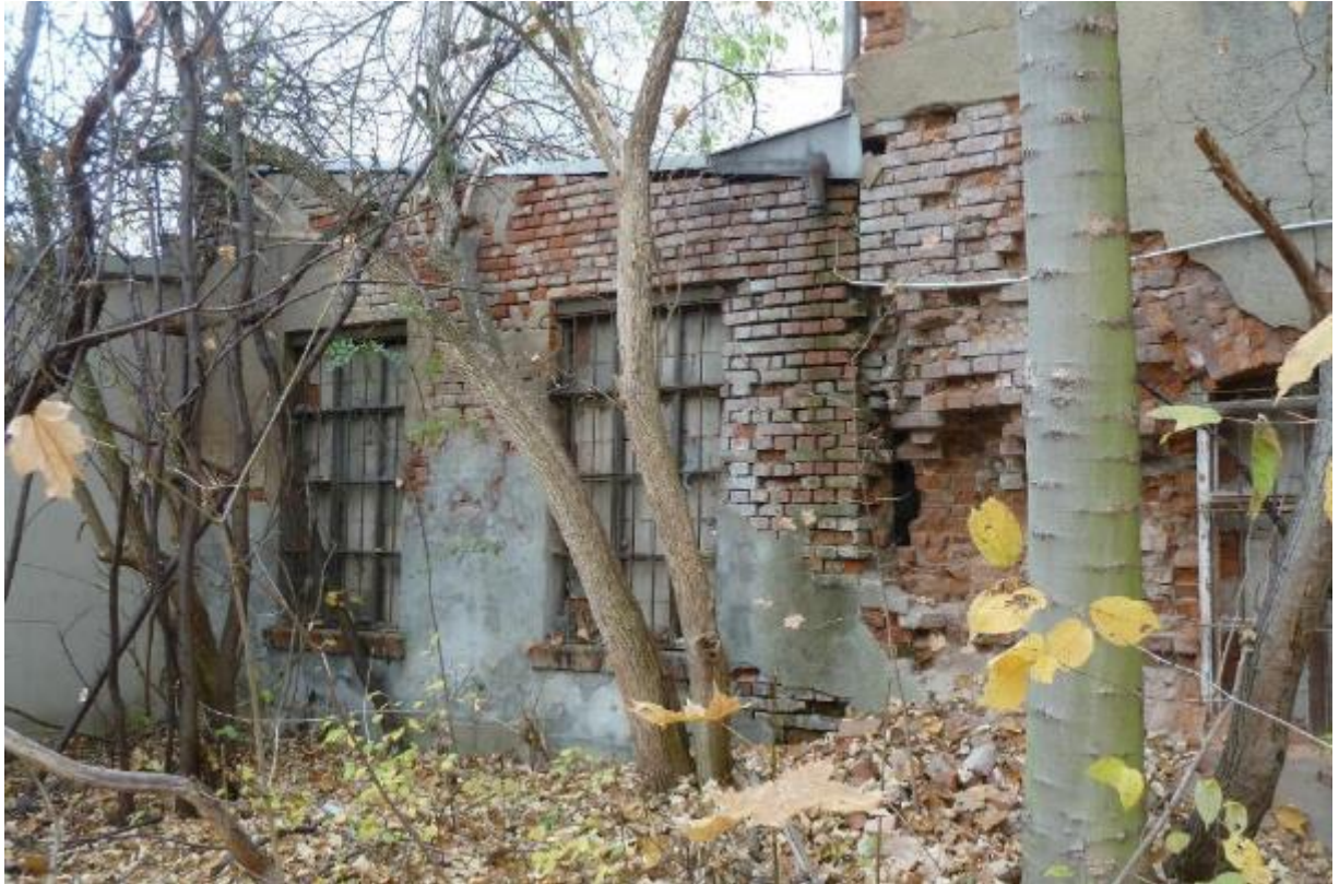
Bild 19, angebaute Kfz-Werkstatt, Ansicht von Süden
