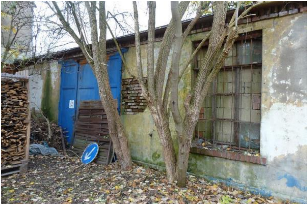
Bild 21, Ansicht der Werkstatt von Osten
