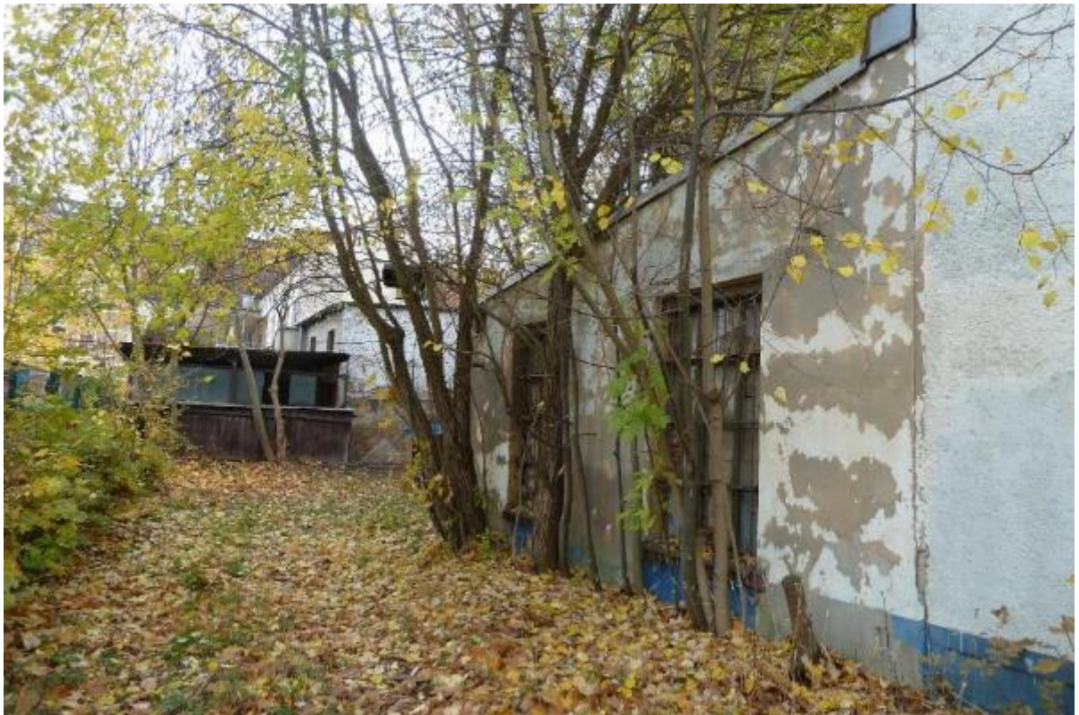
Bild 23, Zufahrtsweg vor dem Giebel der Werkstatt
