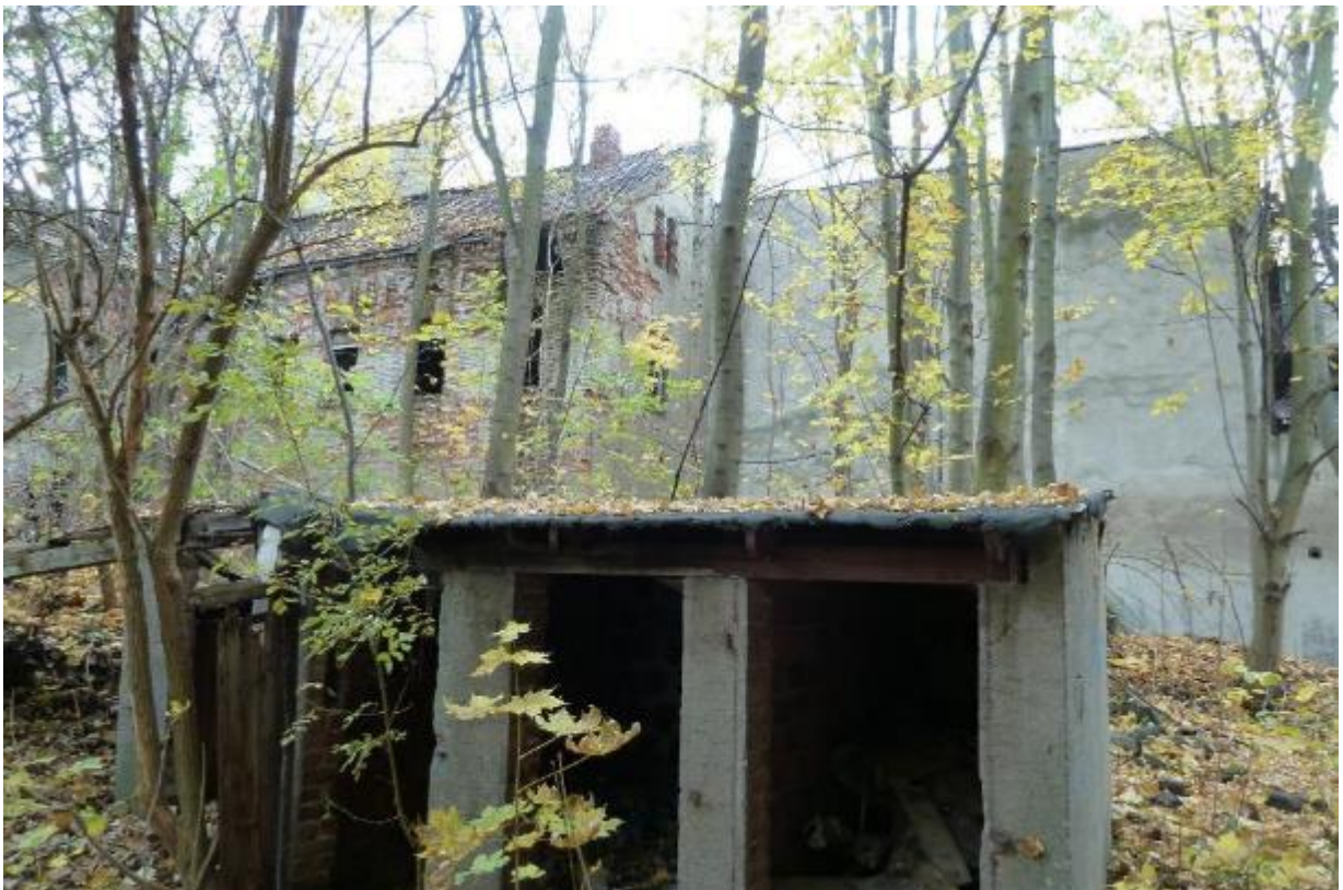
Bild 18, ehemaliger Schuppen auf dem Bewertungsgrundstück, im Hintergrund verfallene Nachbarbebauung
