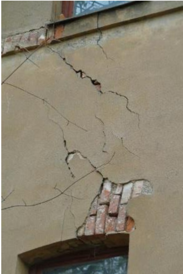
Bilder 15 und 16, Mauerwerksschäden am südlichen Giebel des Wohnhauses
