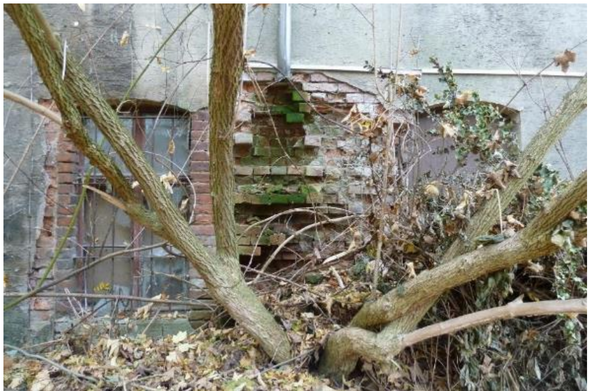
Bild 13, Fassadendetail, Fallrohr an der Ost-Seite des Gebäudes
