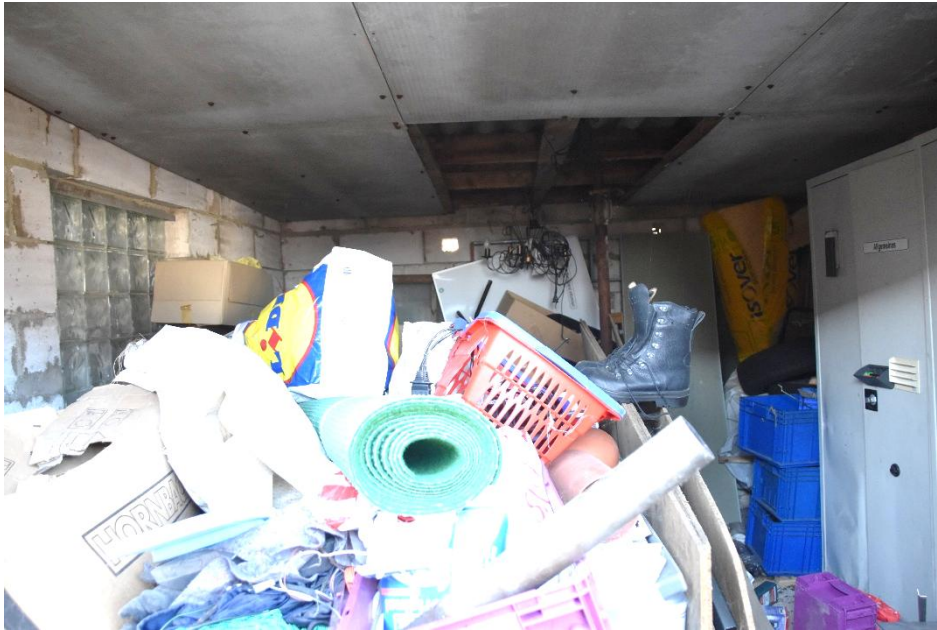
Blick in die Garage
