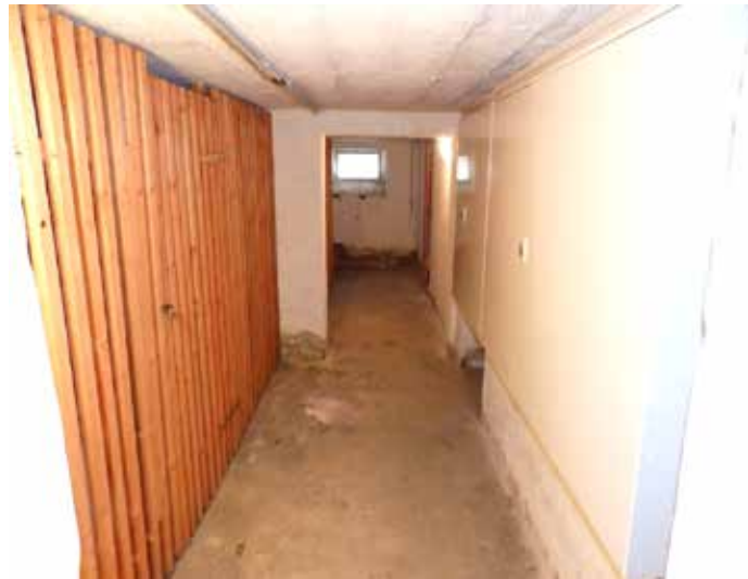
Bild 9: Kellergang des Mehrfamilienhauses (Haus-Nr. 3)
