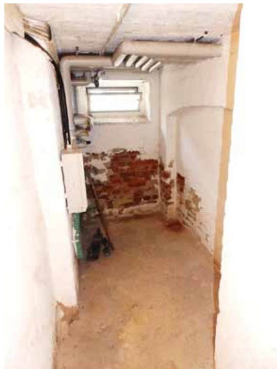
Bild 10: Hausanschlussraum in Haus-Nr. 3
