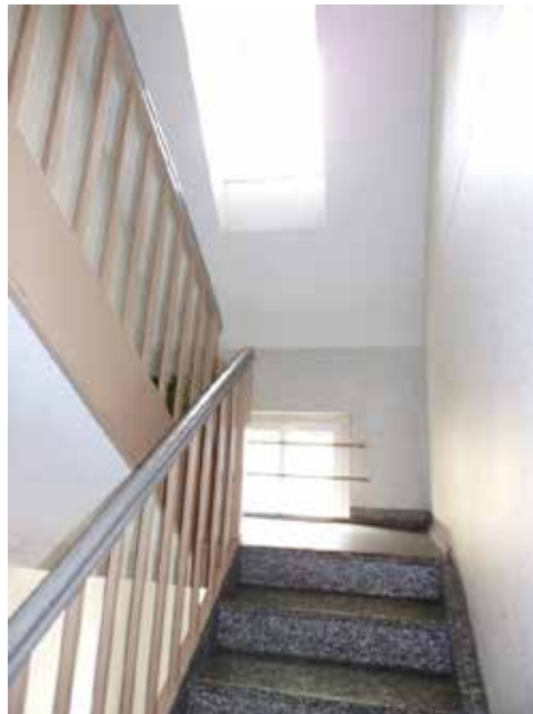
Bild 7: Treppenaufgang des Mehrfamilienhauses (Haus-Nr. 3)
