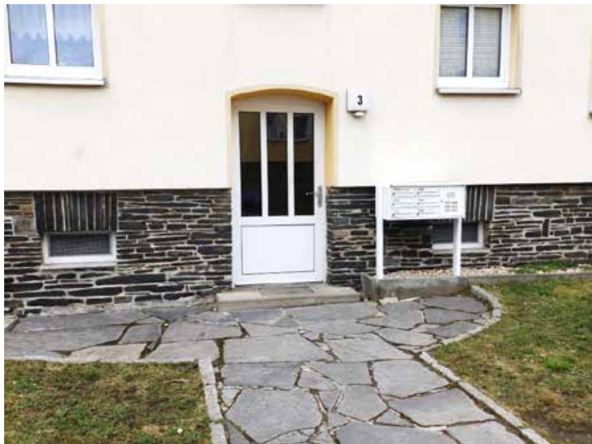
Bild 6: Blick auf den Hauseingang des Mehrfamilienhauses (Haus-Nr. 3)
