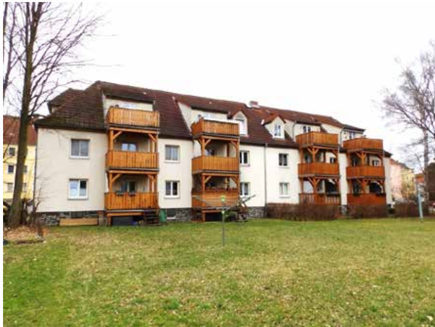
Bild 3: Ansicht des Mehrfamilienhauses vom rückwärtigen Grundstücksteil aus
