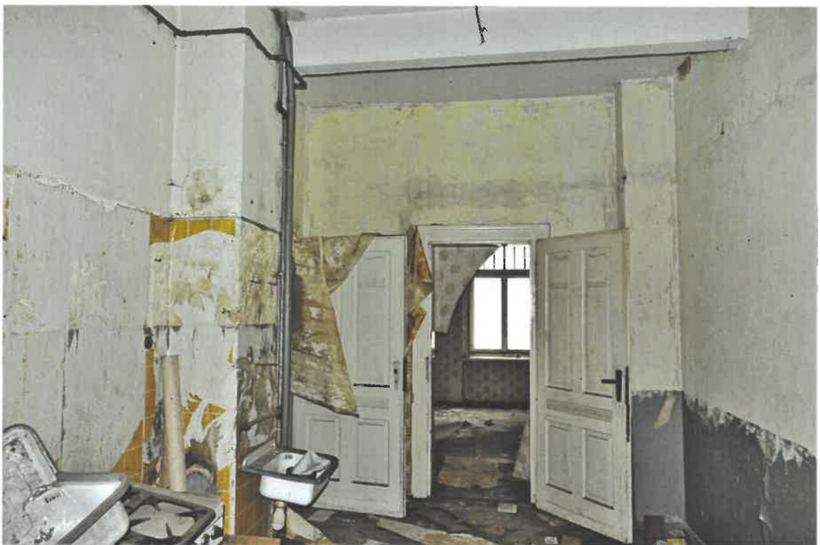
EG, südwestliche Wohnung, hofseitige Küche mit Blick zum straßenseitigen Zimmer
