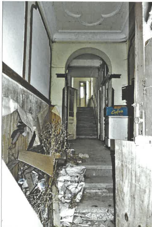
Blick von der Haustüre ins EG mit Treppemhaus
