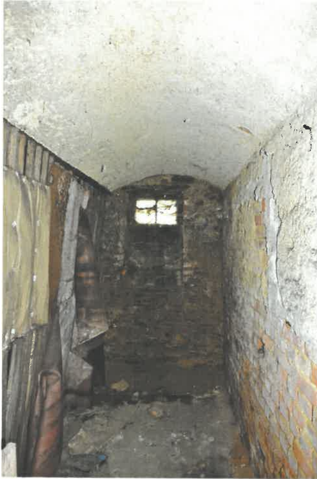
KG, südwestlicher straßenseitiger Kellerraum
