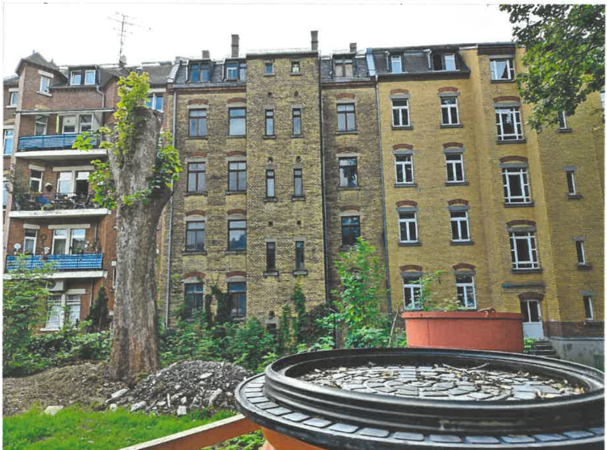
Mehrfamilienhaus (mittig-unsaniert), NW-Ansicht
