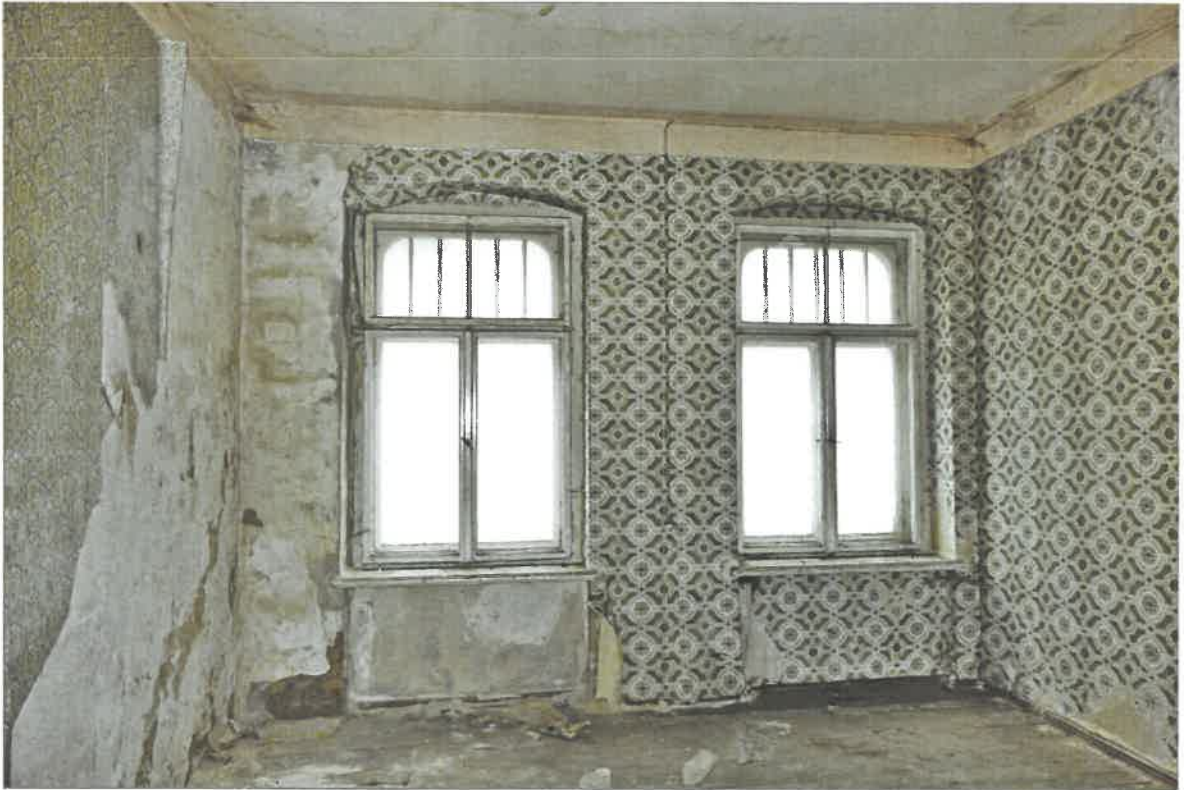
EG, nordöstliche Wohnung, Wohnzimmer zur Straße
