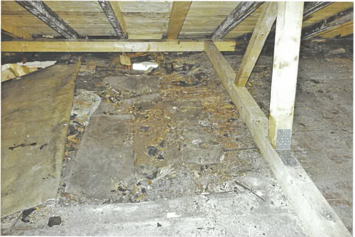
Dachboden, straßenseitiger Bereich
