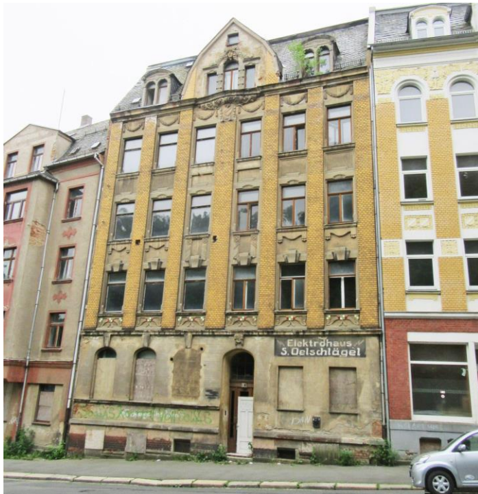
straßenseitige Ansicht nach Norden (aufgenommen zum Ortstermin)
