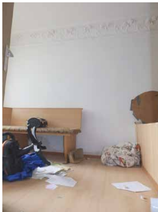
Bild 10: Blick in den Lagerraum der Gewerbeeinheit Nr. 1a
