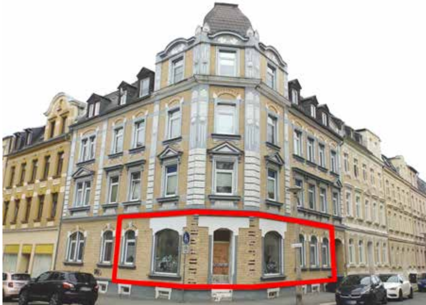
Bild 1: Straßenansicht des Wohn- und Geschäftshauses (mit Kennzeichnung der Lage des Sondereigentums)
