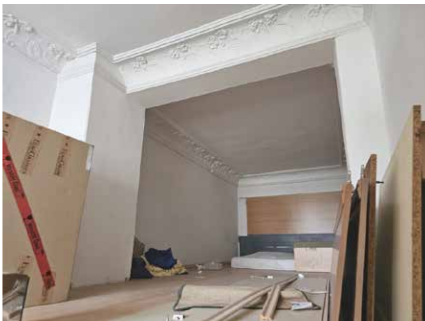
Bild 8: Blick in den Lagerraum der Gewerbeeinheit Nr. 1a
