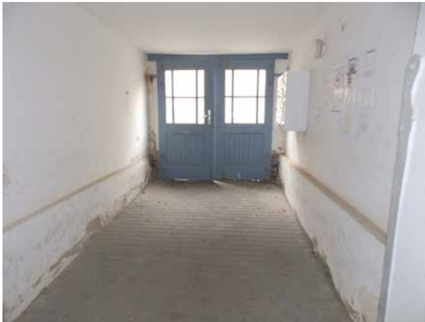
Bild 11: Durchgang von der Straße zum Hof/Garten
