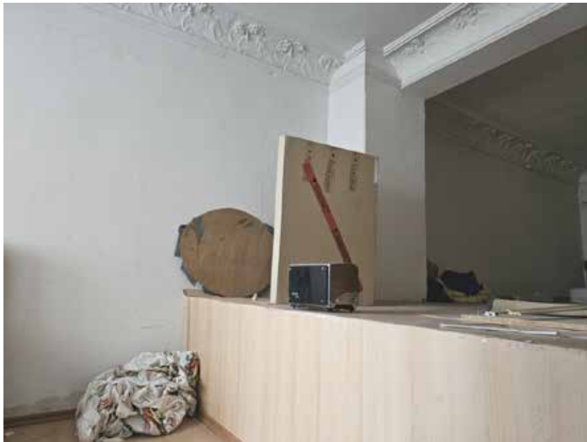
Bild 9: Blick in den Lagerraum der Gewerbeeinheit Nr. 1a
