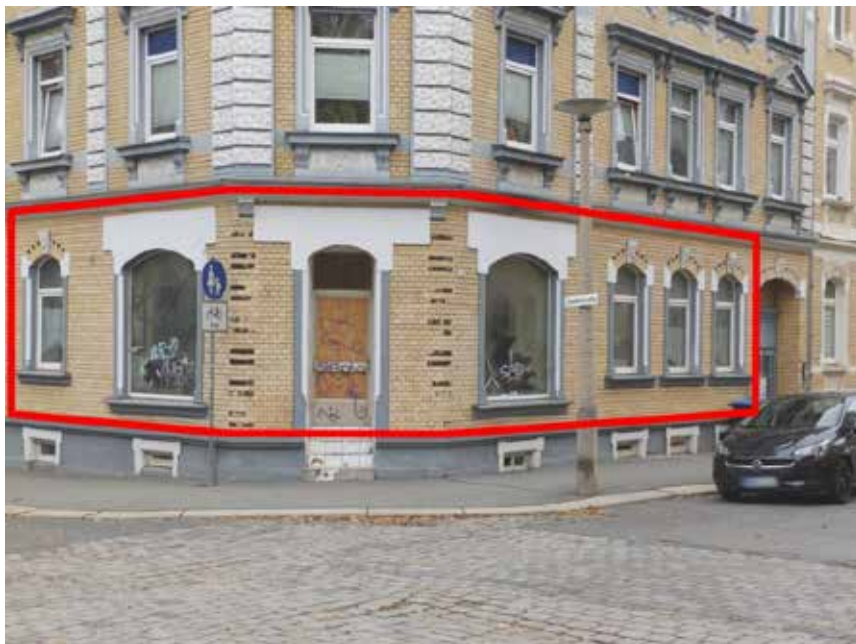
Bild 2: Straßenansicht des Wohn- und Geschäftshauses (mit Kennzeichnung der Lage des Sondereigentums)
