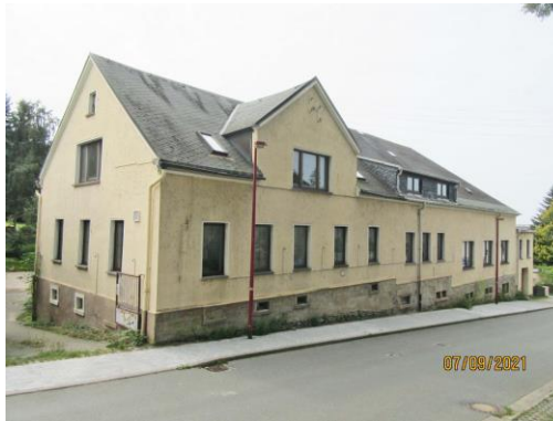
straßenseitige Ansicht nach Osten
