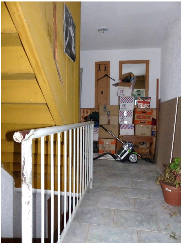
Treppenhaus Obergeschoss im Wohnhaus
