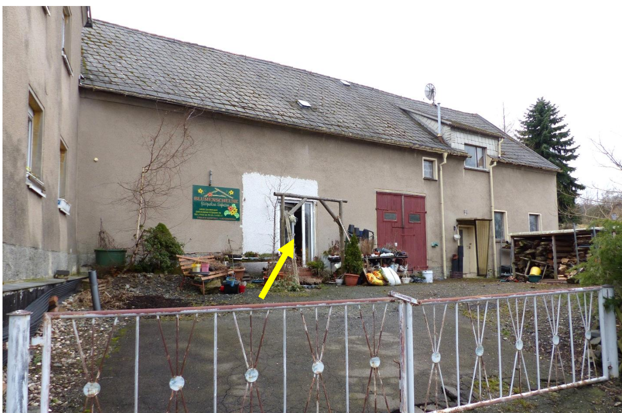
Ansicht von der Straße mit Grundstückszufahrt zum Nebengebäude und Eingang zum Blumenladen (gelb)
