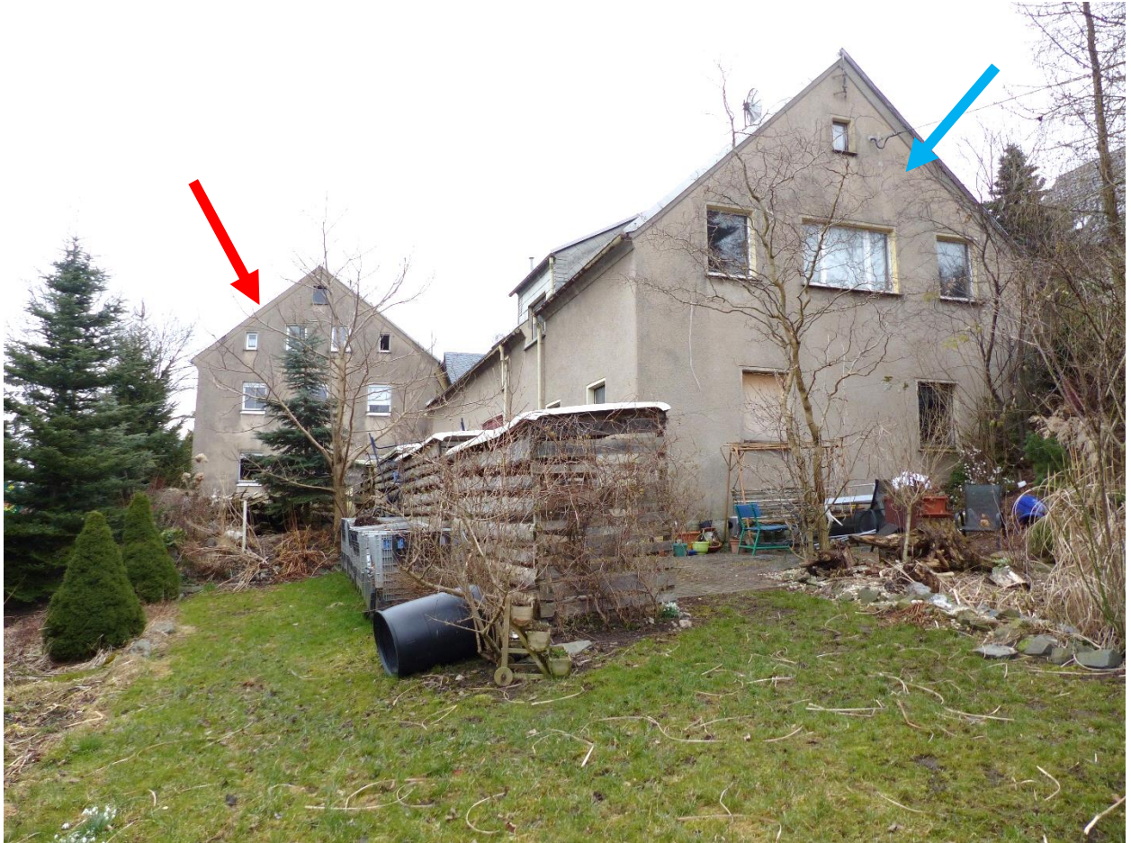
Westsicht zum Wohnhaus (rot) und zum Nebengebäude (blau)
