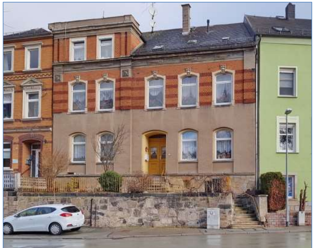
Bild 2 Wohnhaus, Straßenansicht von Süd, Bewertungsobjekt selektiert
