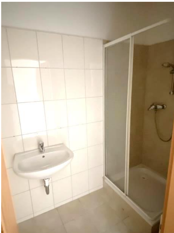
Bild 21, Bad mit Dusche und Waschbecken
