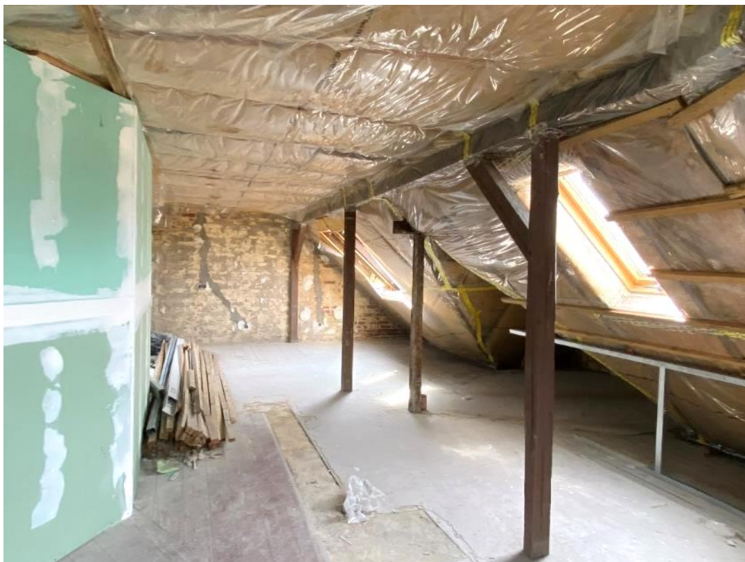
Bild 26, Dachboden, links im Bild Wand zum Treppenhaus
