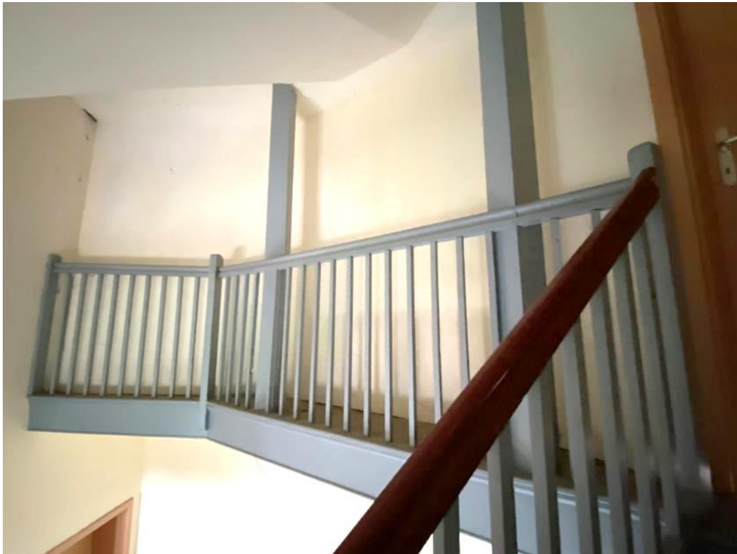
Bild 23, Treppenhaus mit (im Zuge des begonnenen Dachbodenausbaus errichteter) Trockenbauwand zum Dachboden, rechts am Bildrand Tür zum Dachboden
