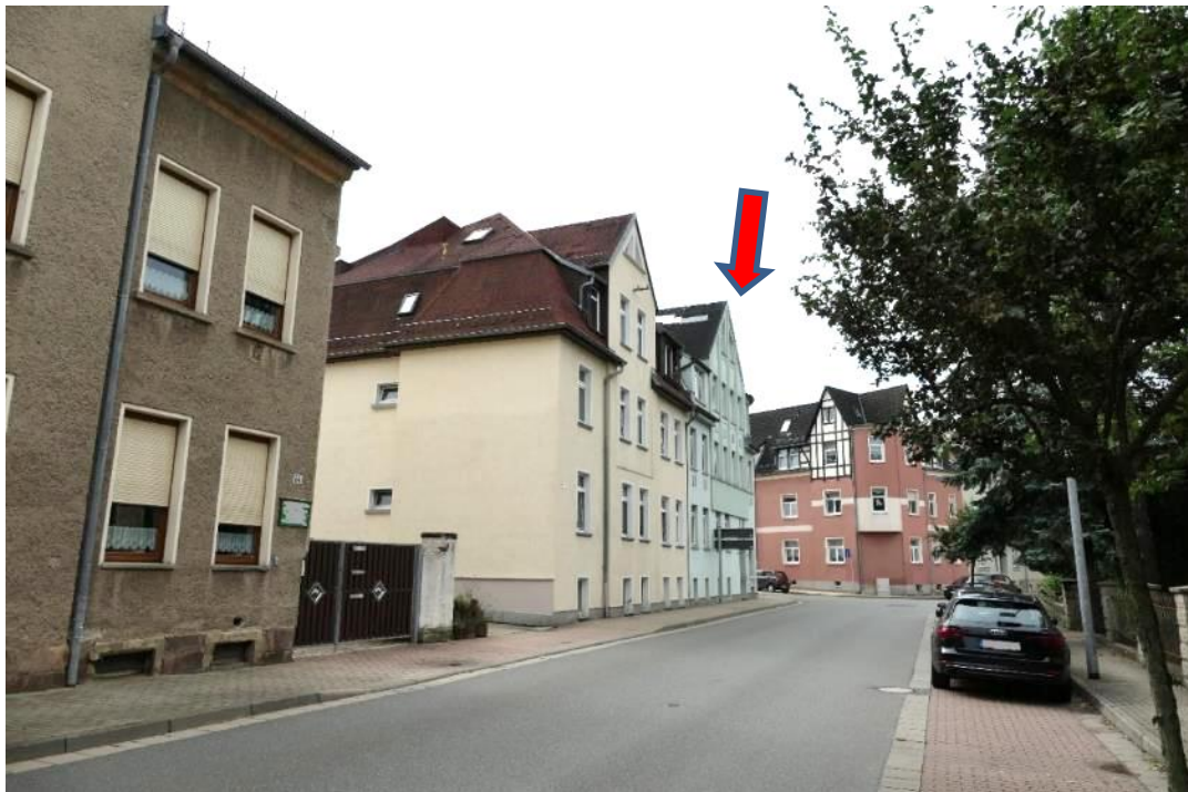
Bild 2, Zufahrt zum Bewertungsgrundstück auf der Kitscherstraße in Richtung Süden
