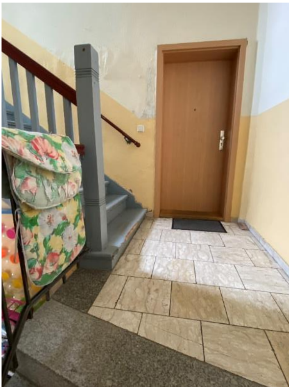
Bilder 10 und 11, Treppenhaus EG mit Tür zur rechts gelegenen Gewerbeeinheit und sichtbaren Feuchtigkeitsschäden an der Wand
