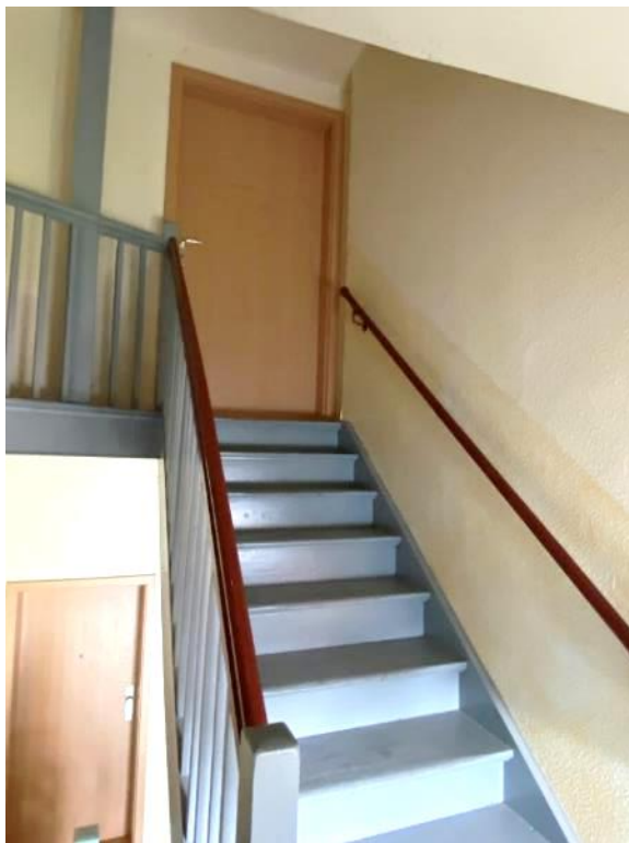
Bild 24, Treppe und Tür zum Dachboden
