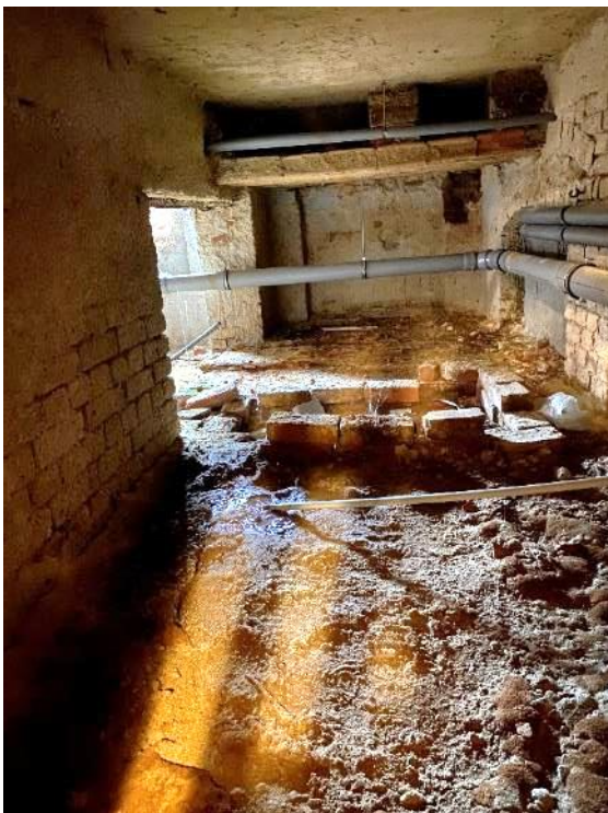
Bild 32, Kriechkeller im straßenseitigen Eckbereich des Gebäudes
