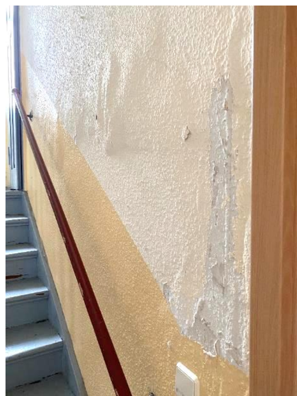
Bilder 10 und 11, Treppenhaus EG mit Tür zur rechts gelegenen Gewerbeeinheit und sichtbaren Feuchtigkeitsschäden an der Wand
