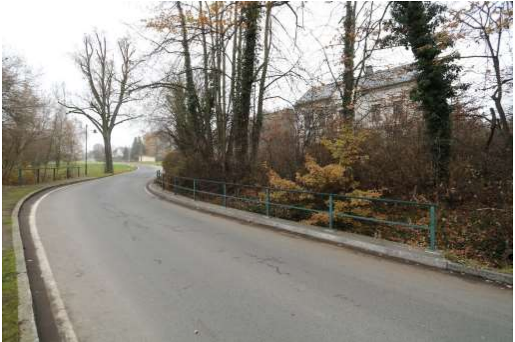
Bachstraße nach West
