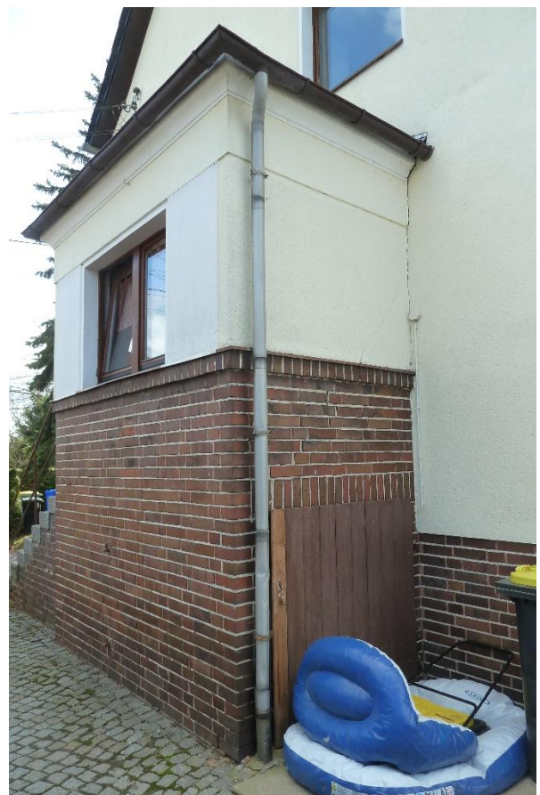
Bild 8, Vorhaus am nördlichen Gebäudegiebel
