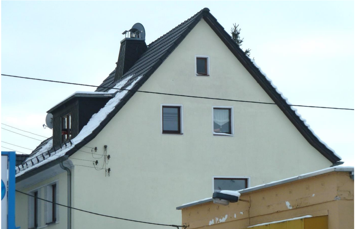
Bild 6, Teilansicht des nördlichen Gebäudegiebels
