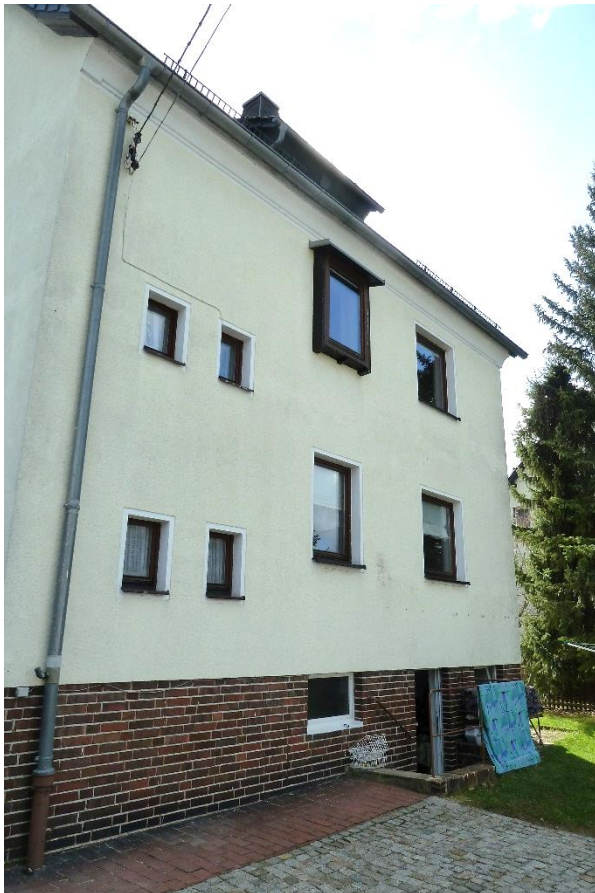
Bild 7, hofseitige Ansicht des Zweifamilienhauses mit Kellerausgangstreppe
