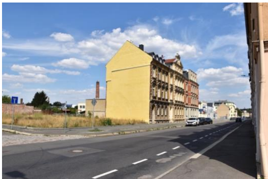
Foto 1: Straßenansicht (Südwestansicht) mit umgebender Bebauung
