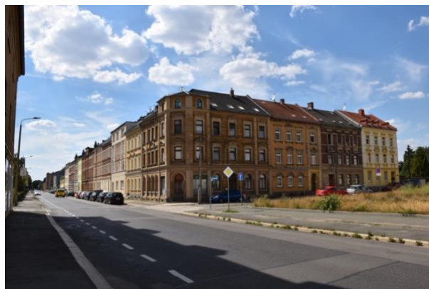
Foto 9: Ostansicht mit umgebender Bebauung an der Auestraße und Jägerstraße
