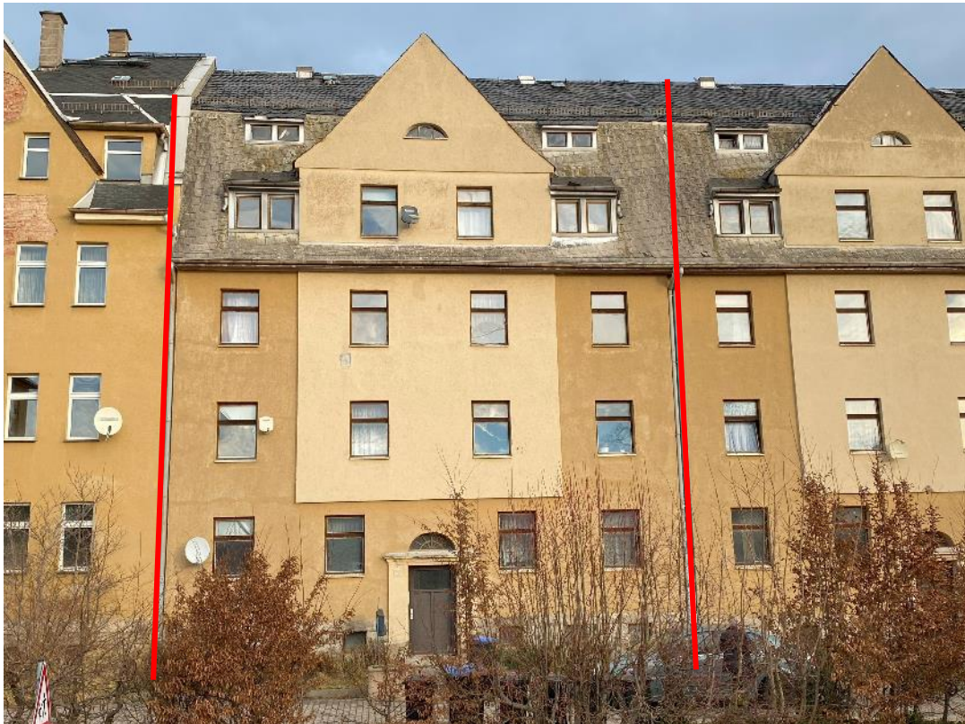
Bild 3, straßenseitige Ansicht des Bewertungsjekts von Süden
