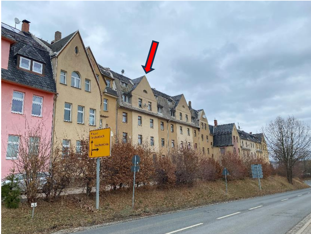
Bild 1, Ansicht des Gebäudekomplexes Hohe Straße von der Elsterberger Straße mit Kennzeichnung der Lage des Bewertungsobjekts
