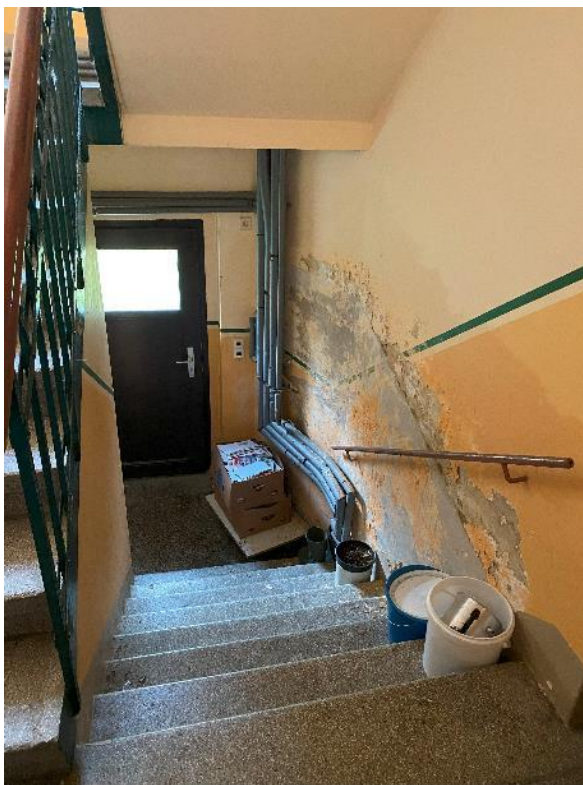
Bild 9, Treppe zum Hinterausgang
