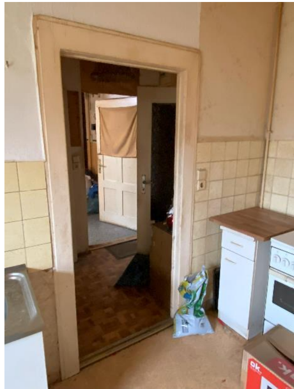
Bild 17, Blick von der Küche in den Flur
