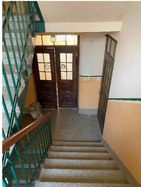
Bild 8, Erdgeschoss, Blick auf Tür zum Windfang
