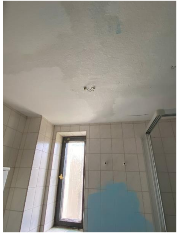
Bilder 25 und 26, Bad mit Wasserschaden
