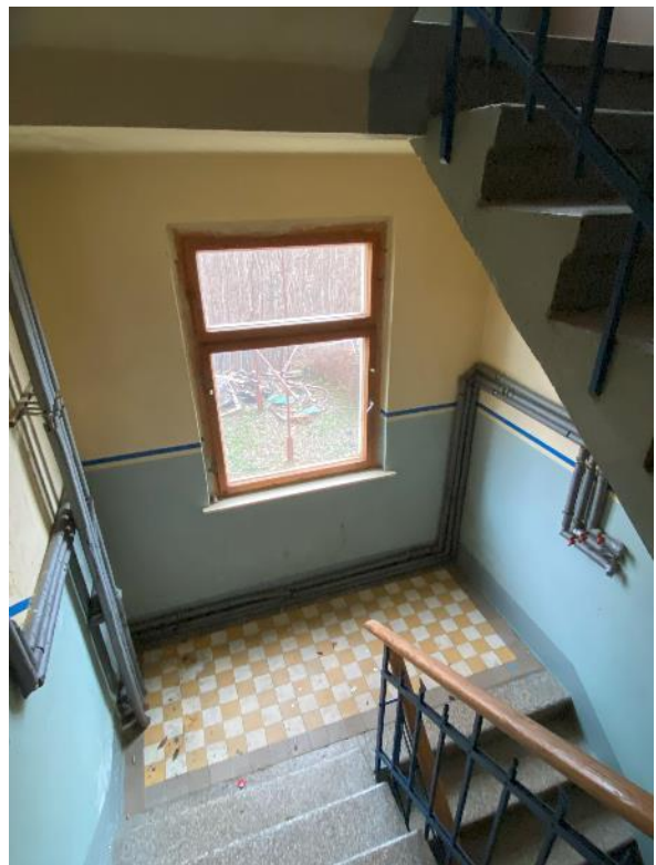
Bild 13, offene Leitungsführungen (Heizung und Warmwasser)
