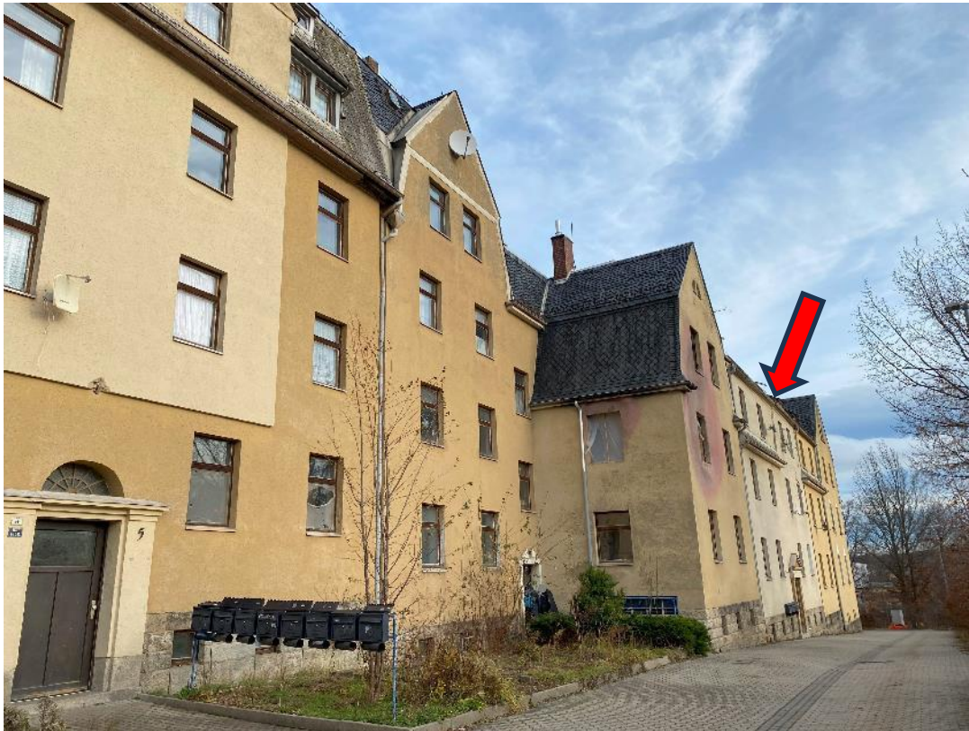
Bild 5, Zufahrt auf der Hohen Straße in Richtung Osten mit Kennzeichnung der Lage des Gebäudes Hohe Straße 7
