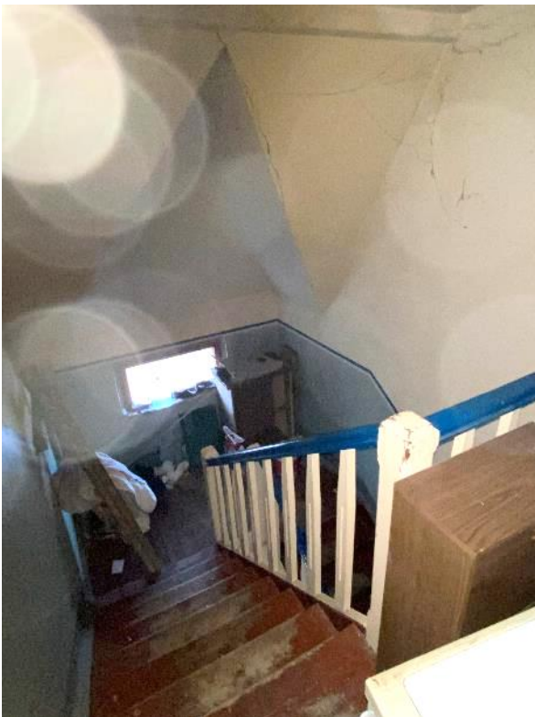
Bild 16, Holztreppe zum Dachboden
