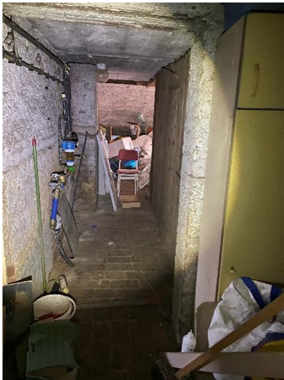
Bild 33, Flur mit Trinkwasseranschluss
