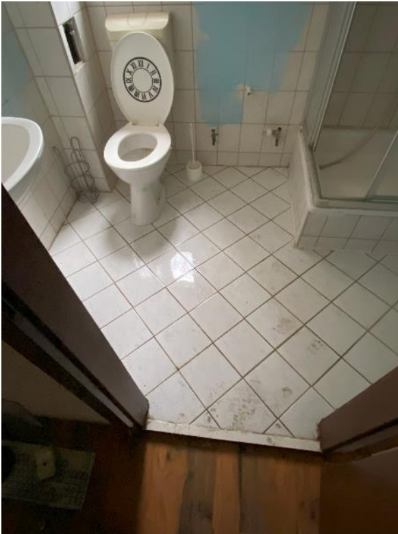
Bilder 25 und 26, Bad mit Wasserschaden
