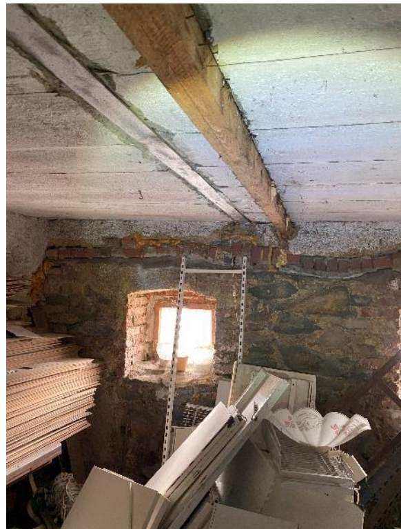
Bild 34, nachträglich eingebaute Sperrung in der Außenwand
