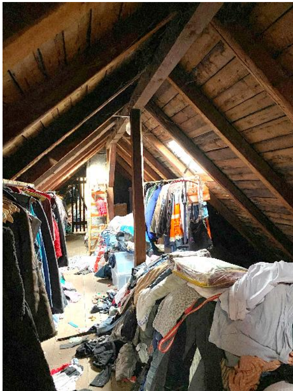
Bild 31, im Spitzboden lagern Altkleider
