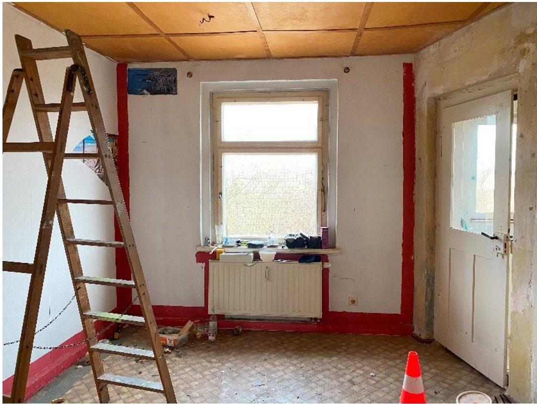
Bild 21, Küche mit Tür zum Waschraum
