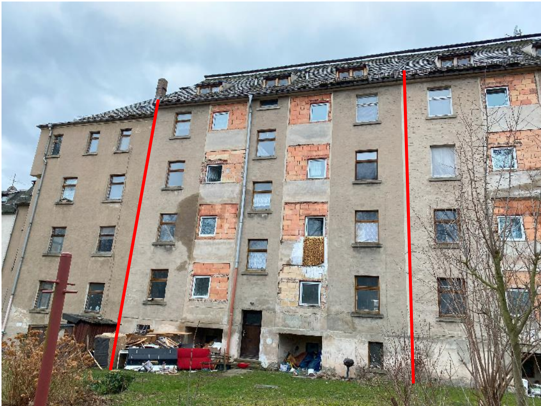
Bild 6, Gebäuderückansicht von Norden
