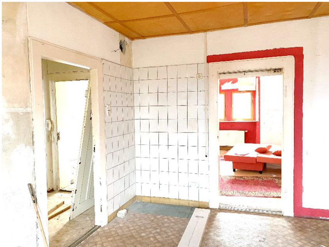
Bild 22, Küche mit Türen zum Flur (links) und in einen Wohnraum
