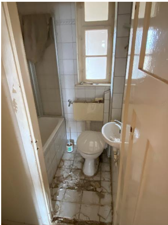
Bild 25, Bad mit Fenster zum Waschraum
