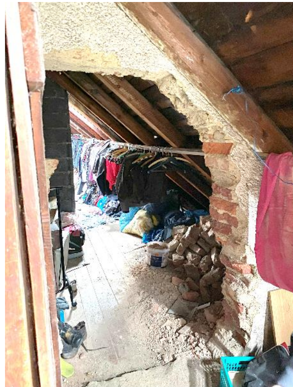
Bild 32, offener Durchbruch zum Nachbargebäude Hohe Straße 4
