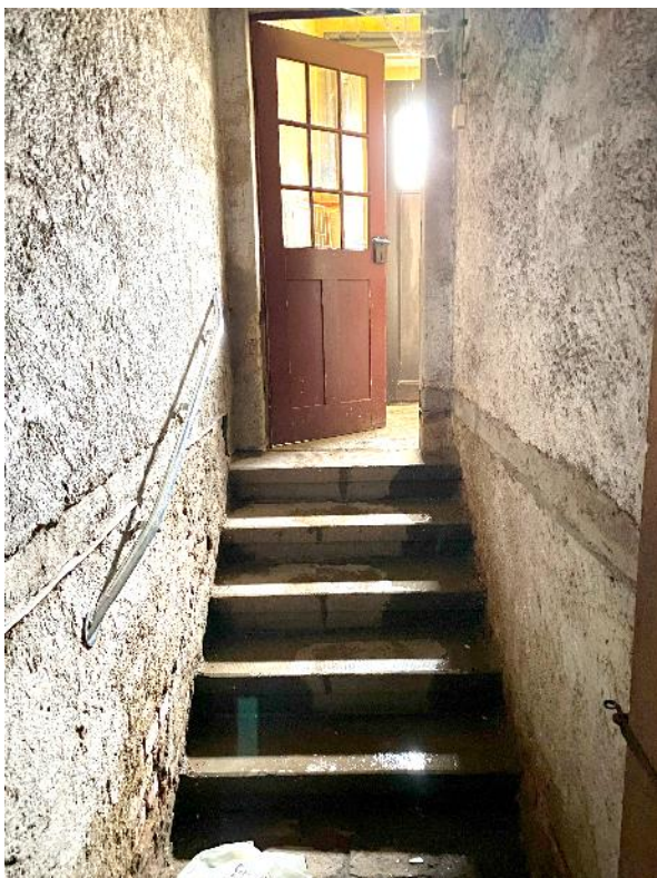
Bild 33, Kellertreppe mit Tür zum Treppenhaus
