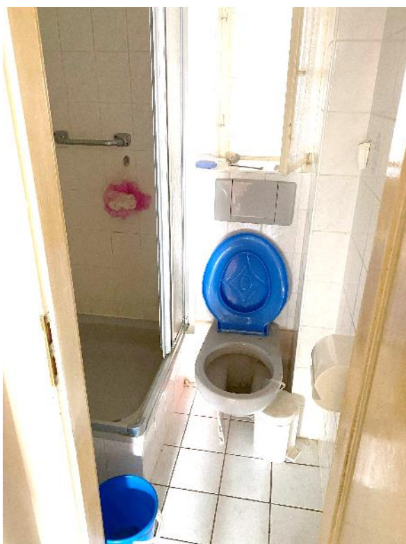
Bild 19, Bad mit Fenster zum Waschraum
