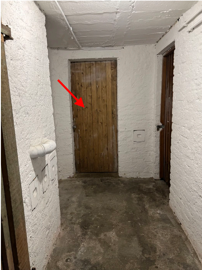
Abb. 13 Kellergeschoss, Ansicht Zugangstür zu Kellerraum Nr. 5
