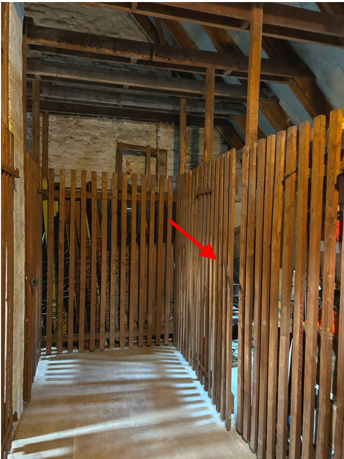
Abb. 14 Dachgeschoss, Teilansicht Bodenabstellräume und Lage des der Wohnung Nr. 5 zugeordneten Bodenabstellraumes
