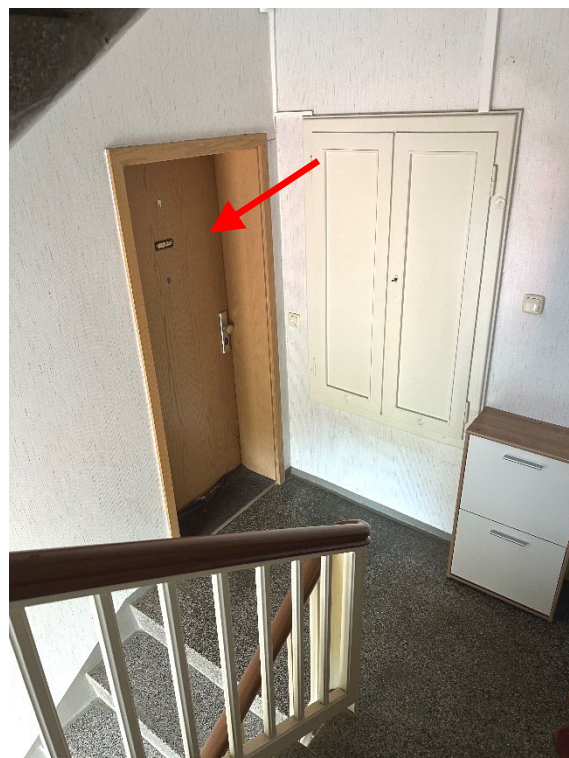
Abb. 06 Teilansicht Treppenhaus im 2.OG Hauseingang Rathausstr. 2 und Ansicht Zugang zu Wohnung Nr. 5
