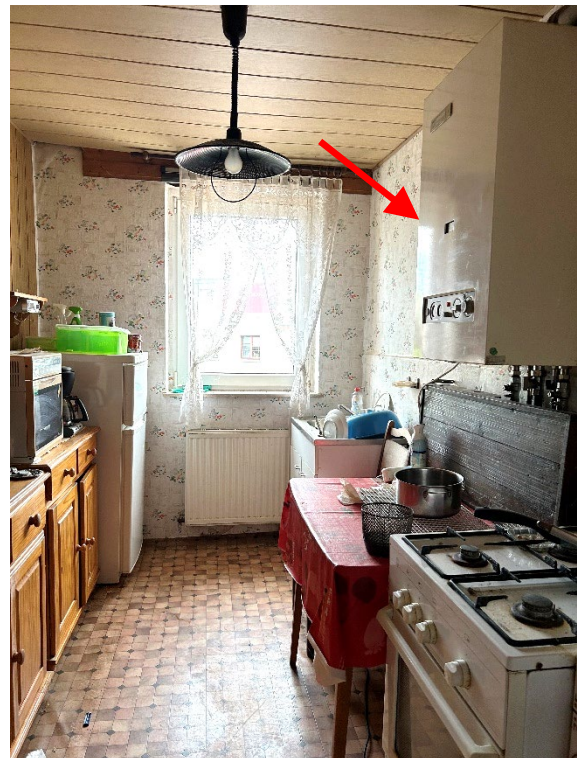
Abb. 08 Wohnung Nr. 5, Teilansicht der Küche und Anordnung der Gastherme
