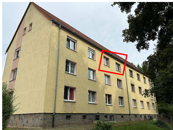
Abb. 03 Gebäuderückseite Haus Rathausstraße 2,4 und Lage der Wohnung Nr. 5 im 2.OG, Haus Rathausstr. 2, Osten
