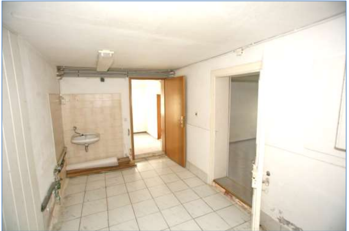
Bild 9 Raum im Erdgeschoss
