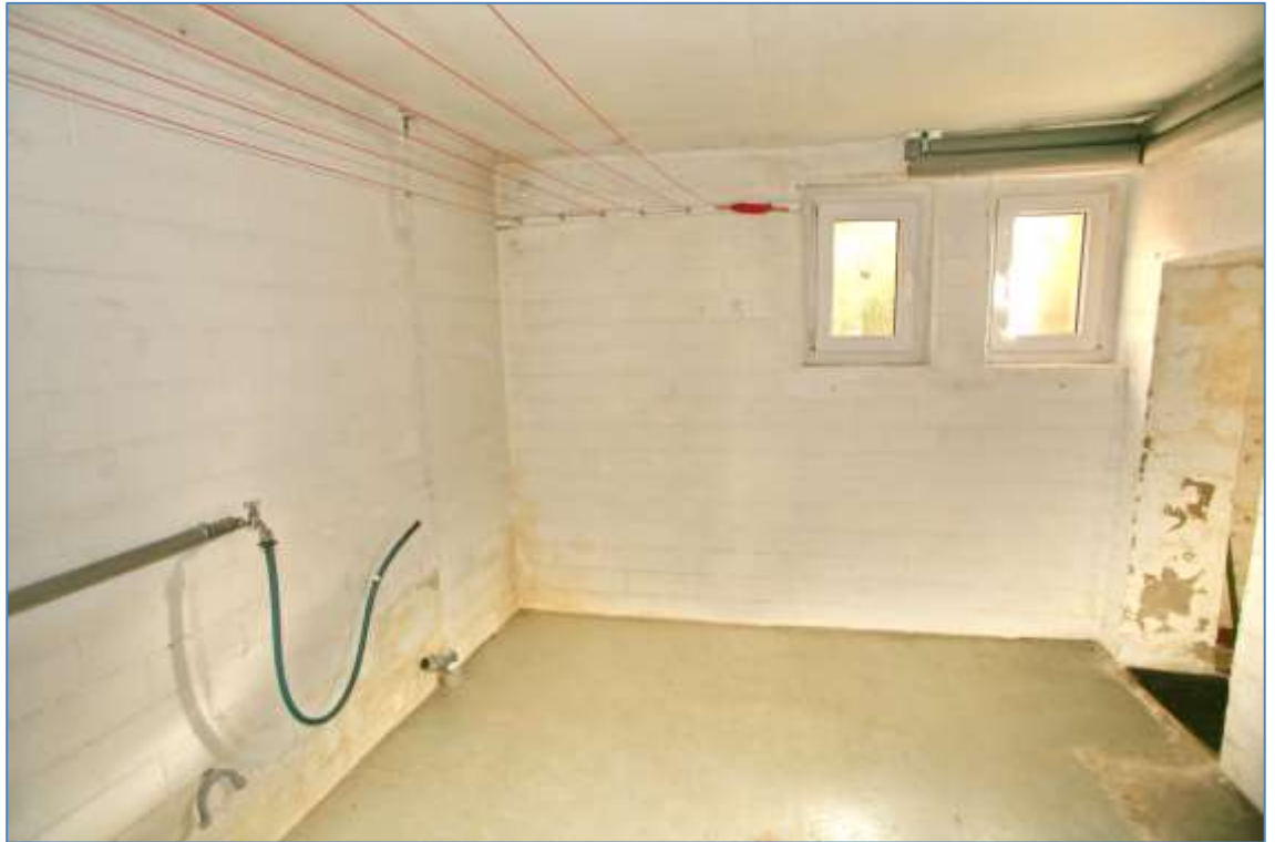
Bild 11 Raum im Erdgeschoss
