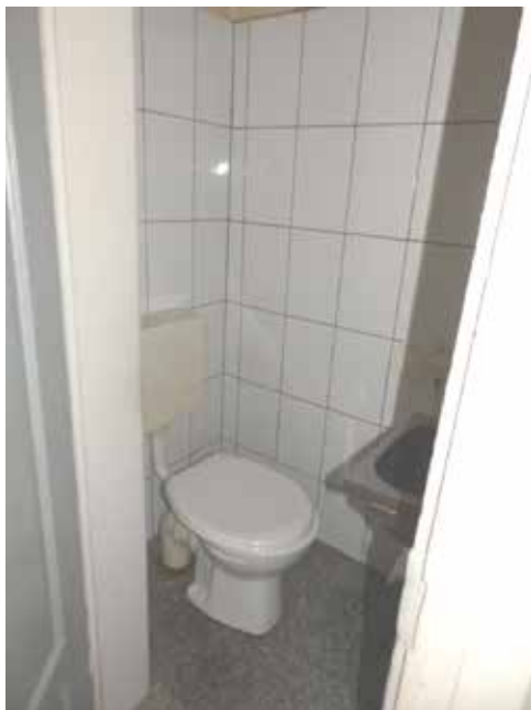
Bild 23: WC (Treppenhaus EG)
