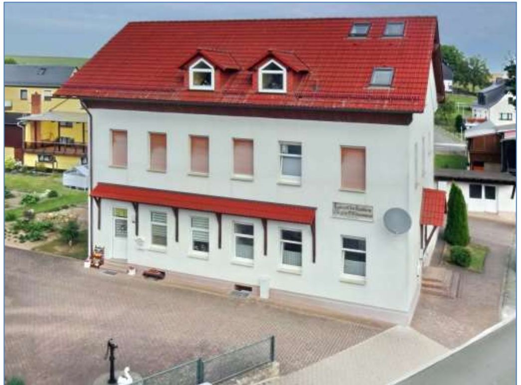
Bild 1 Eigentumswohnanlage, Straßenansicht als Hochbild
