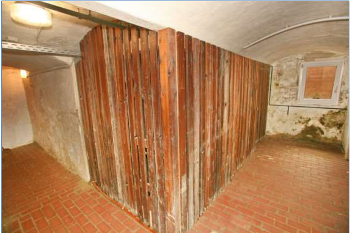
Bild 7 Kellergeschoss, Kellerraum (römisch) 5
