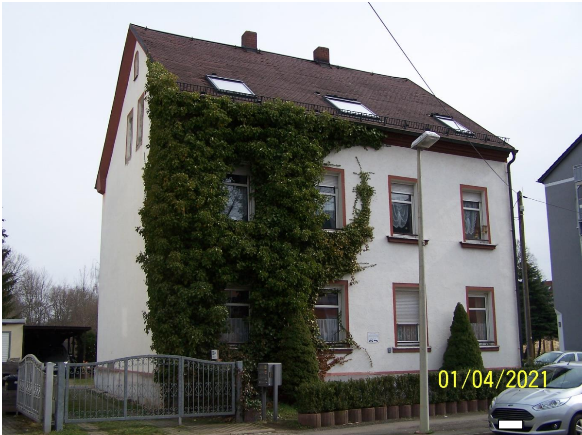
11K 22/21 Vorderansicht, 08058 Zwickau, Brückenstr. 11
