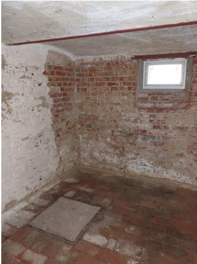
Kellerraum für Wohnung Nr. 2
