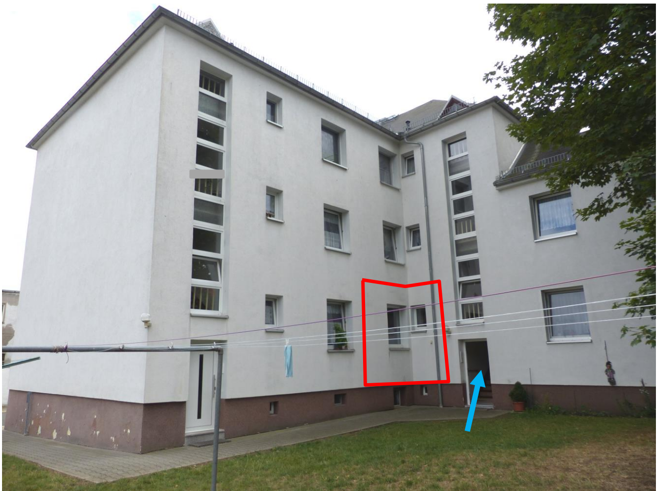
Nord-Ansicht vom Wäscheplatz zur Wohnung Nr. 2 (rot); Hauseingang „Karolinenstraße 20“ (blau)
