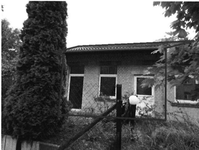
Hintergebäude mit ETW-Nr. 7 vorderseitig links
