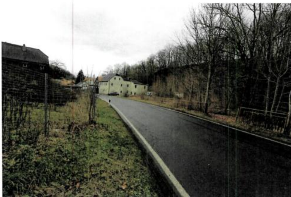
Wildenfelser Straße nach Süd-West
