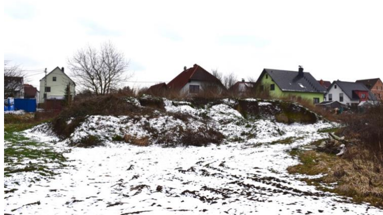
Foto 5: Blick in südlicher Richtung mit abgelagerten Bodenaushub
