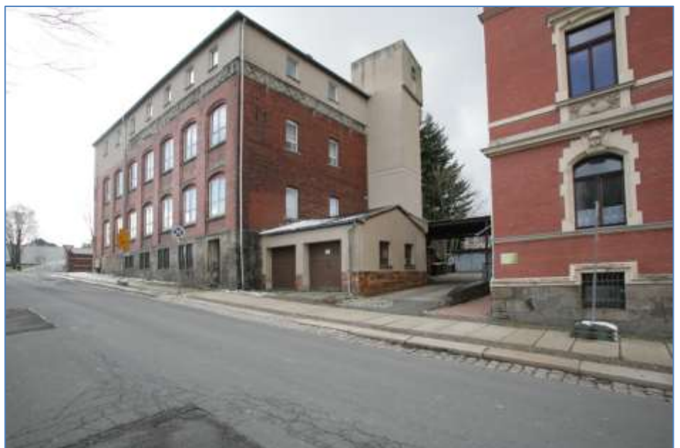
Bild 4 Industriebrache mit Garagenanbau, Ansicht von der Dorfstädter Straße von Nordwest
