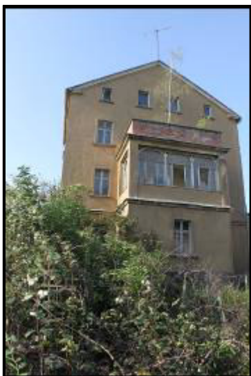
Detailansicht seitlicher Anbau (Veranda)
