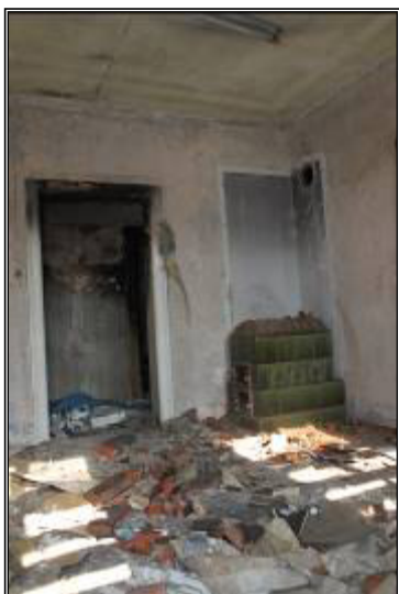
Teil der Innenansicht (Blick durch das Fenster)
