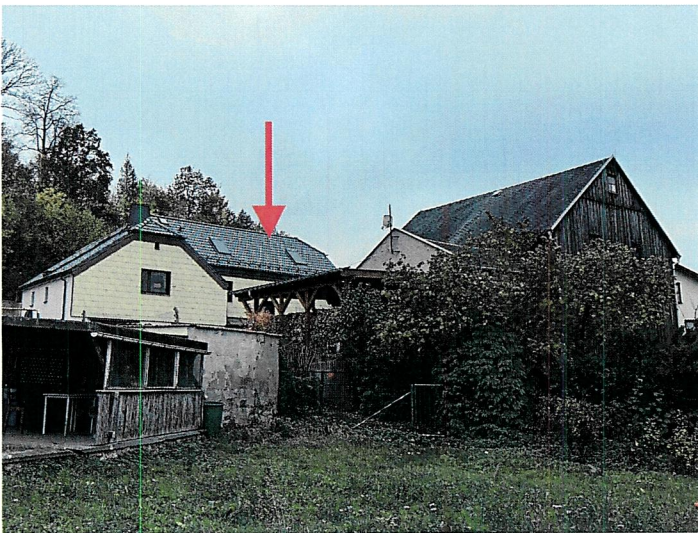
Abb. 01 Ansicht des Grundstücks von Nordosten mit Teilansicht Wohngebäude auf der Hofseite und Teilansicht Scheune mit Anbauten sowie Carport
