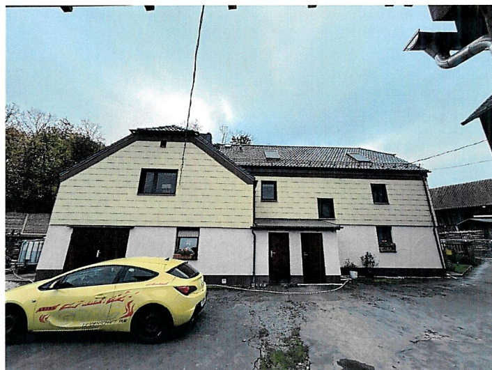
Abb. 07 Ansicht Wohngebäude von Norden/ Hofseite (Foto erstellt vom Eigentümer)
