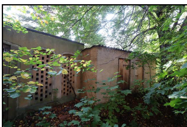
Teil des Nebengebäudes
