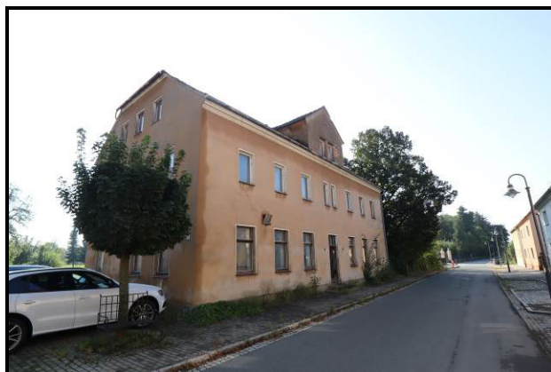
Nord-West-Ansicht des Bewertungsobjekts
