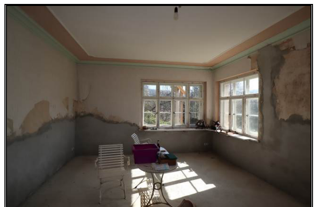
Rohbauzimmer der EG-Wohnung
