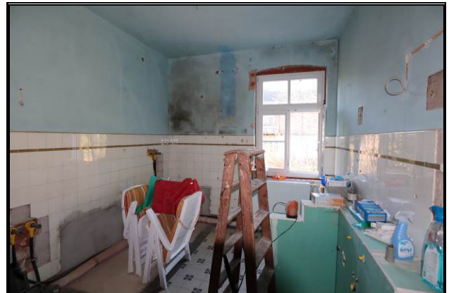
Rohbau-Bad der OG-Wohnung
