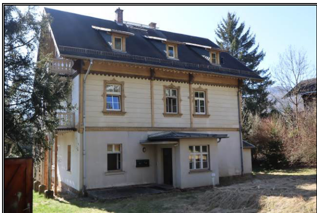
Nord-Ansicht des Bewertungsobjekts
