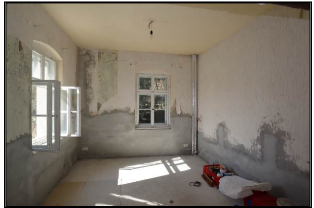
Rohbauzimmer der EG-Wohnung
