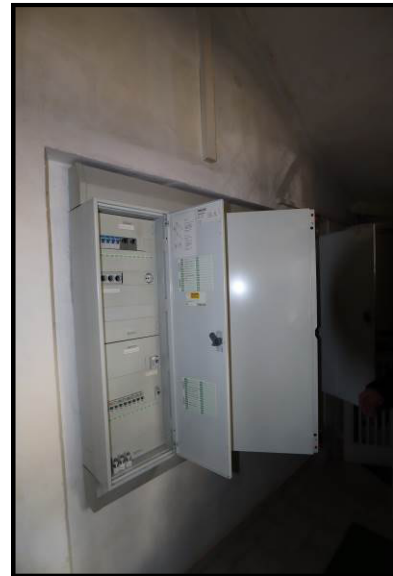
Detailansicht Zählerschrank
