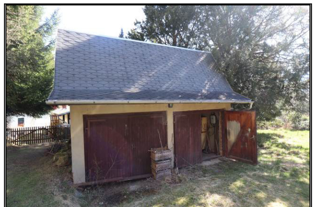
West-Ansicht der Doppelgarage
