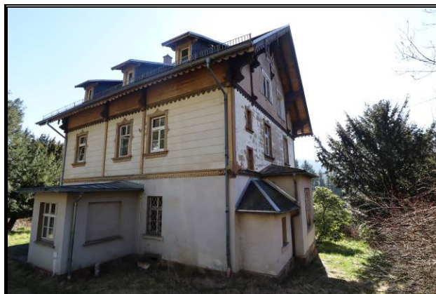
Nord-West-Ansicht des Bewertungsobjekts
